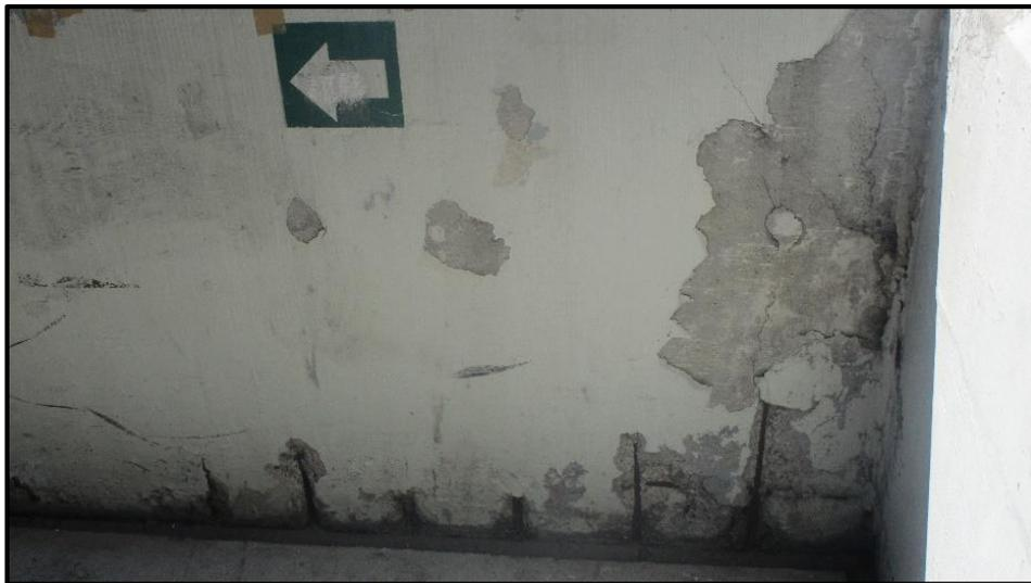
Figura 3.37 Deterioro del concreto y corrosión del acero en muro. (DE-DICYG, 2018)
