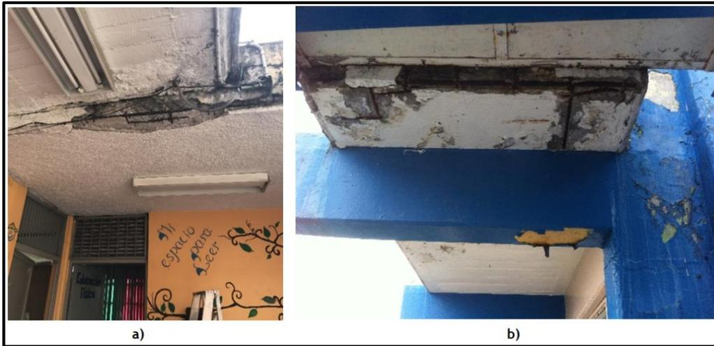
Figura 1.31 Daño en losas por corrosión del acero y pérdida de recubrimiento. (CICM-SMIE, 2018)
