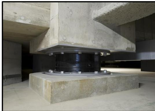
Figura 1.52 Aislamiento sísmico. (IngeCivil, 2018)
