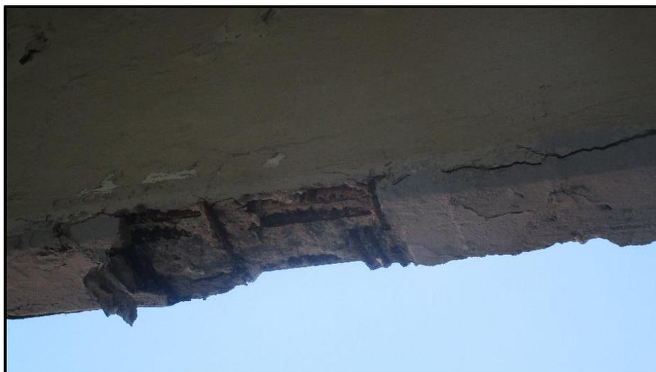
Figura 3.39 Pérdida de recubrimiento y corrosión en el acero, en pretiles. (DE-DICYG, 2018)
