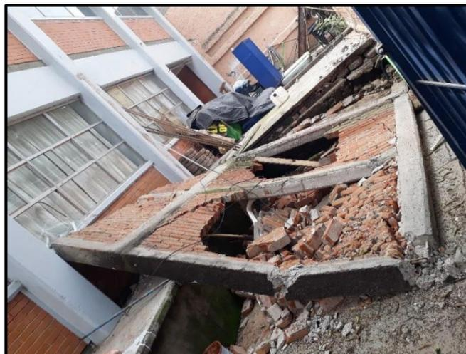
*Figura 1.40 Derrumbe de muro de mampostería. (CICM-SMIE, 2018)*
