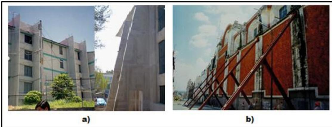
Figura 1.48 a) contrafuertes externos de concreto (AF-CENAPRED); b) Contrafuertes de acero (Acrosa, 1999)
