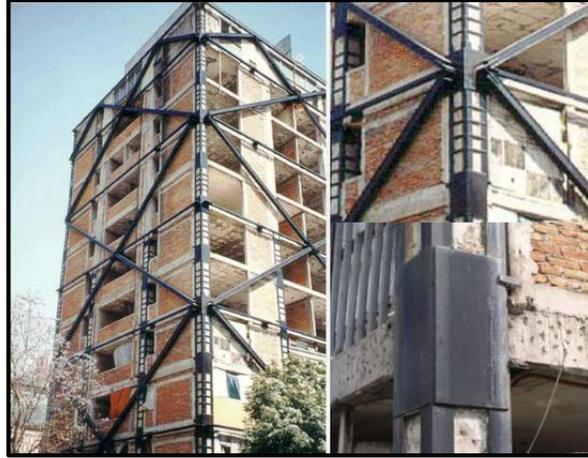
Figura 1.49 Edificio con contraventeos y encamisados de columnas. (AF-CENAPRED)
