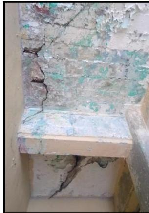
Figura 1.30 Grietas por tensión diagonal en losa de concreto. (CICM-SMIE, 2018)
