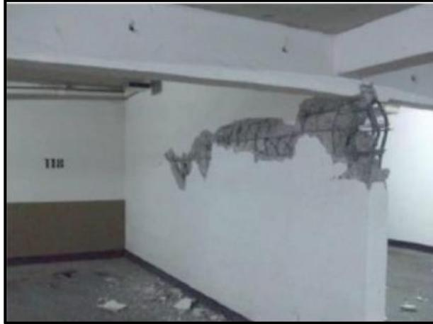
Figura 1.23 Efecto en muro transversal. Edificio Sol Oriente, Santiago. (SciELO.org)
