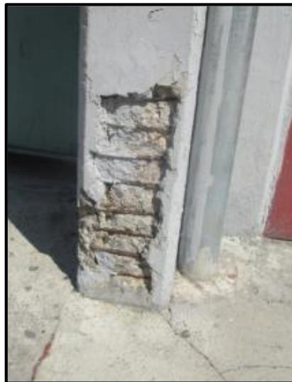
Figura 3.34 Pérdida de recubrimiento y corrosión del acero en la base de la columna del eje D. (DE-DICYG, 2018)
