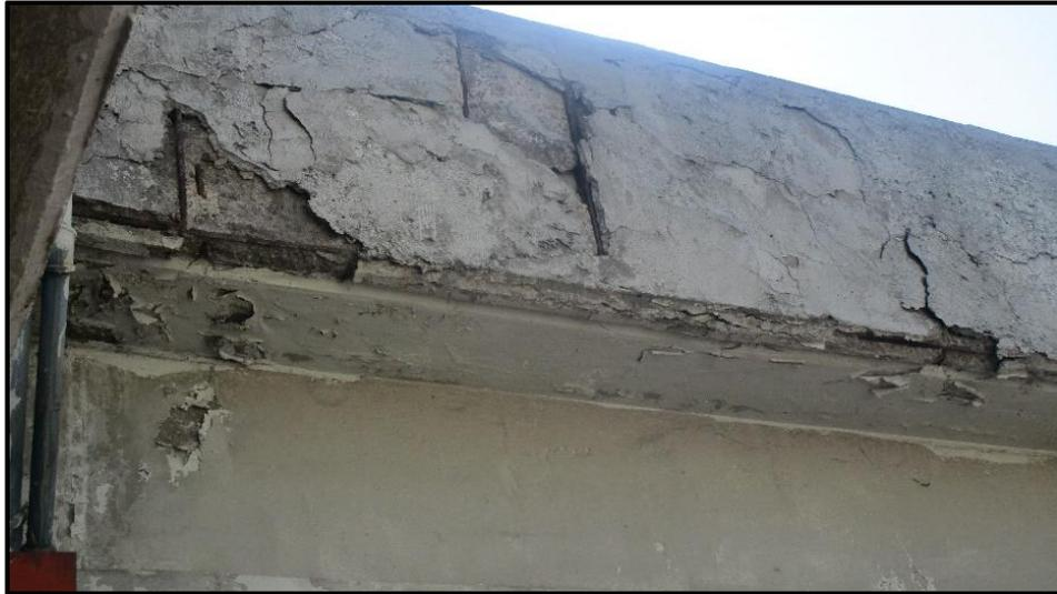
Figura 3.30 Daños por deterioro del concreto y corrosión del acero. (DE-DICYG, 2018)
