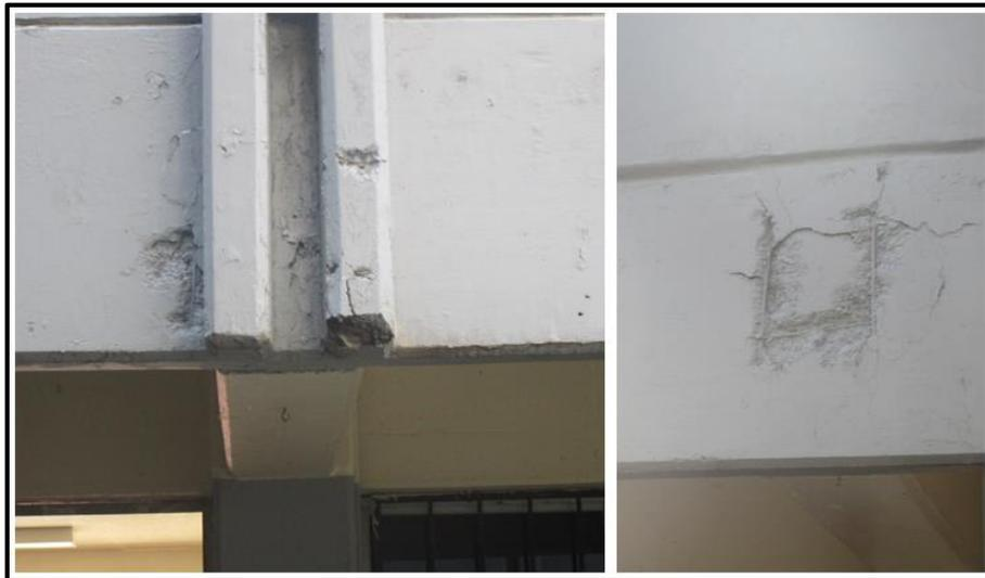
Figura 3.22 Daños preexistentes, deterioro del concreto y pérdida de recubrimiento debida a la corrosión del acero. (DE-DICYG, 2018)
