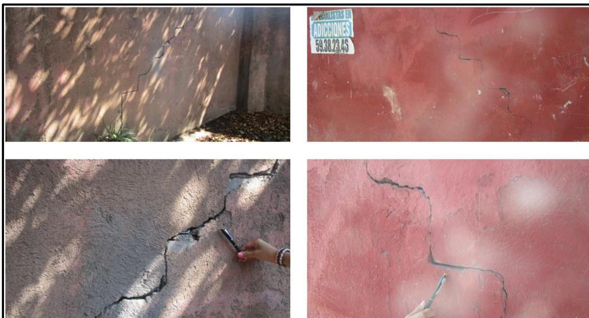
Figura 4.40 Daños en bardas por asentamientos diferenciales o desplomos. (DE-DICYG, 2018)
