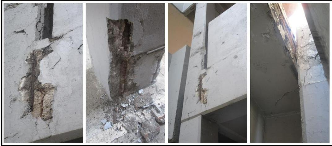
Figura 3.36 Daños por deterioro del concreto y corrosión del acero en la columna B4 (columna 32). (DE-DICYG, 2018)
