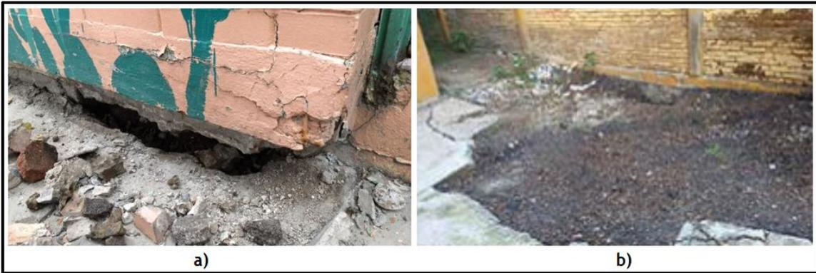
Figura 1.35 a) Asentamiento del terreno circundante b) socavación en esquina suroeste del plantel. (CICM-SMIE, 2018)
