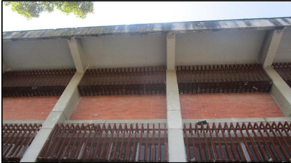
Figura 3.21 Daños preexistentes, deterioro del concreto debido a escurrimientos pluviales. (DE-DICYG, 2018)
