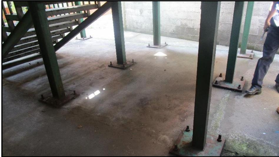
Figura 4.24 Falta de mantenimiento en la escalera metálica de emergencia, existencia de corrosión. (DE-DICYG, 2018)
