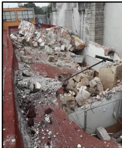
Figura 1.32 Derrumbe parcial de la losa de concreto. (CICM-SMIE, 2018)
