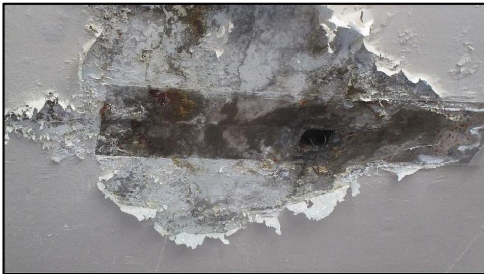
Figura 3.31 Daños por corrosión del acero debido a escurrimientos pluviales y falta de mantenimiento. (DE-DICYG, 2018)
