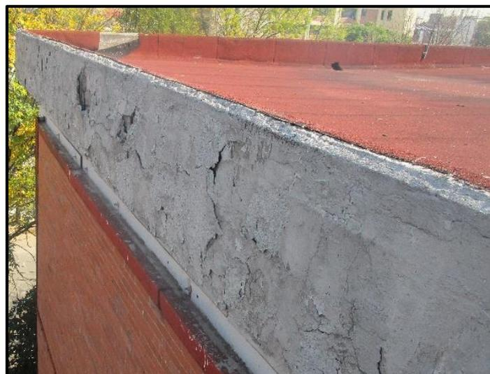
Figura 3.29 Daños preexistentes, deterioro del recubrimiento. (DE-DICYG, 2018)
