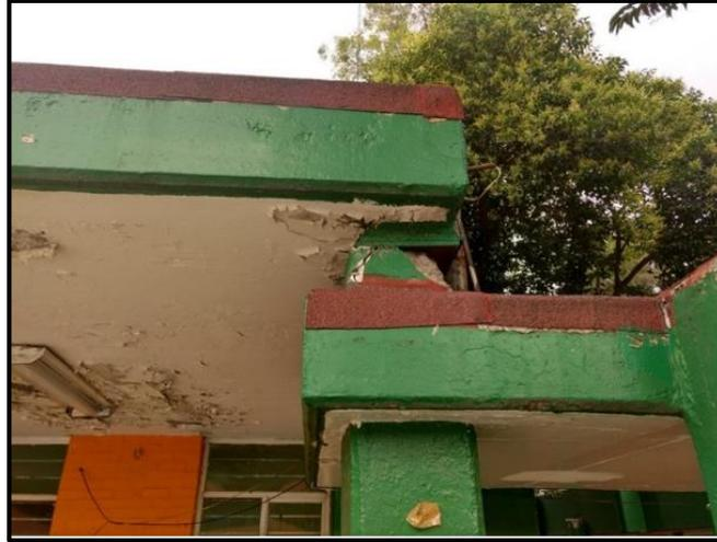
Figura 1.27 Daño en columna por efecto de columna corta. (CICM-SMIE, 2018)
