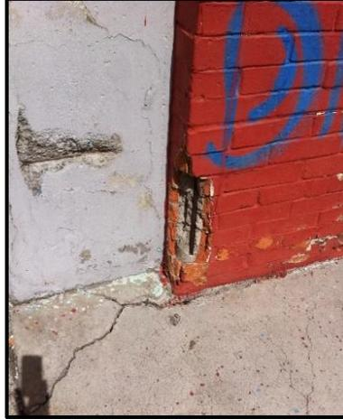
Figura 1.37 Pérdida del recubrimiento y exposición de acero confinado en muro de mampostería. (CICM-SMIE, 2018)
