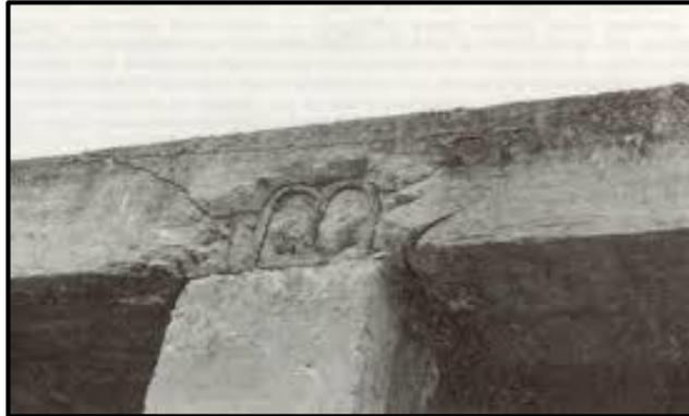
*Figura 1.20 Desconchamiento del concreto en la unión viga-columna. (Temo Correa)*
