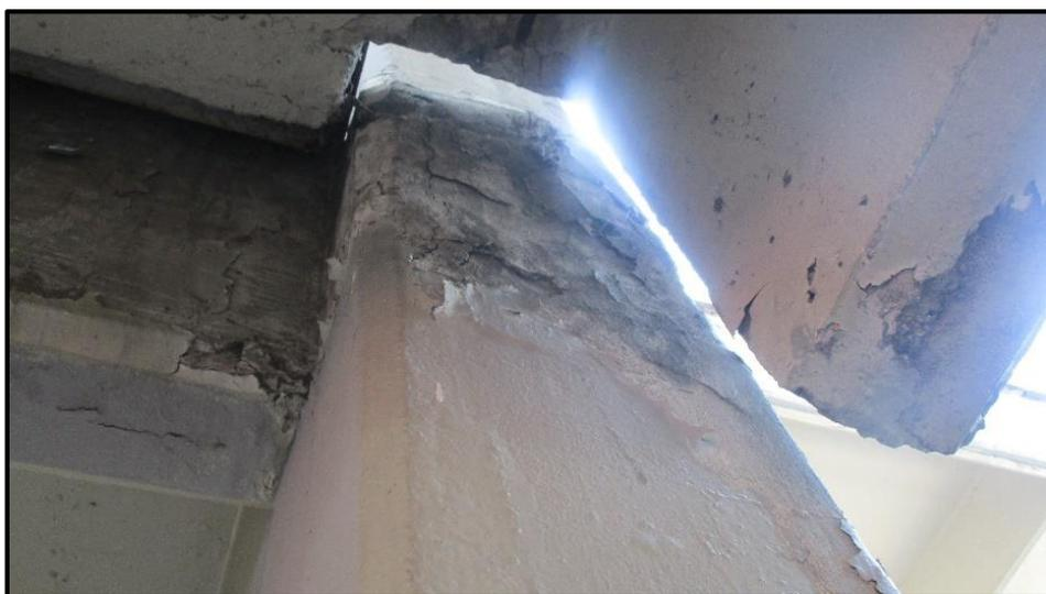
Figura 3.38 Deterioro del concreto, pérdida de recubrimiento en juntas constructivas y corrosión del acero debido a escurrimientos pluviales y movimientos relativos entre cuerpos. (DE-DICYG, 2018)
