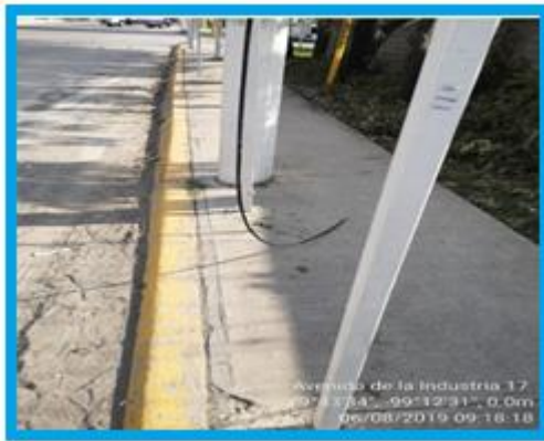
Figura 14. Corte de Fibra derivado de una poda de árbol.
