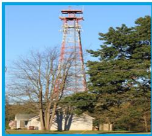
Figura 11. Antena de AT&T Long Lines
