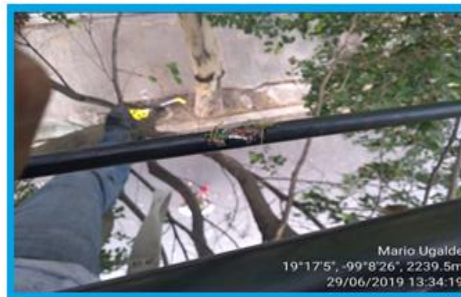
Figura 15. Corte de Fibra por roedores.
