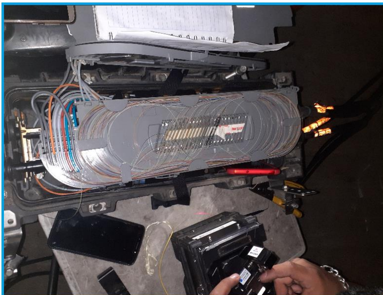
Figura31. Personal de Planta Interna realizando el empalme de la fibra óptica dañada. Fuente: Intranet. Datos propios de la empresa.
