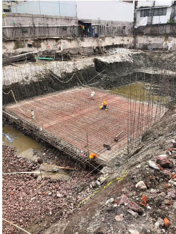
**Figura 37. Construcción de la losa por etapas**
