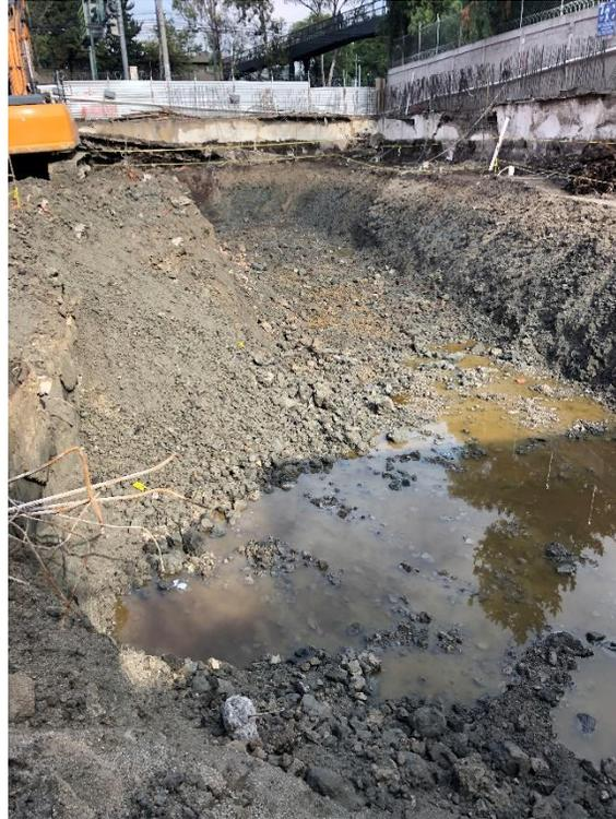
***Figura 39. NAF en la excavación***
