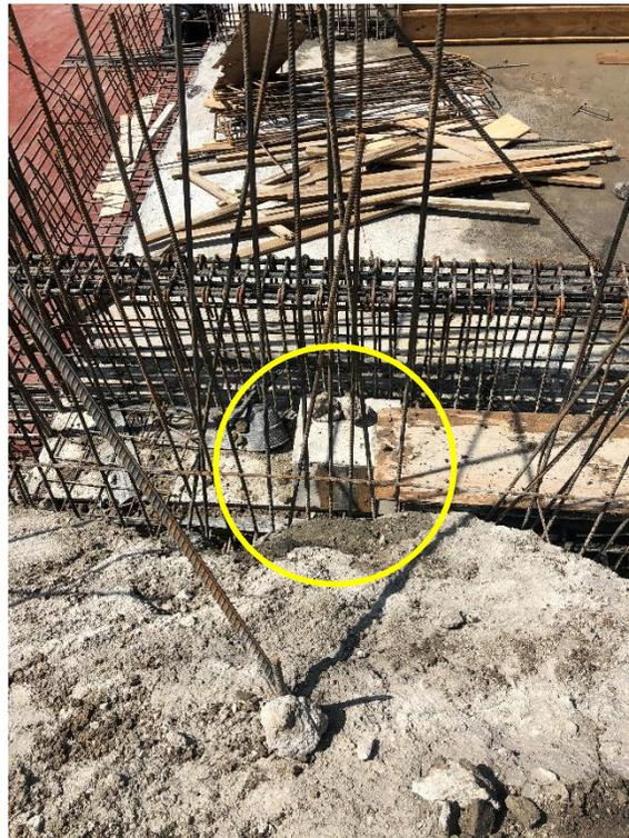
**Figura 38. Preparación en losa para colocación de troqueles**
