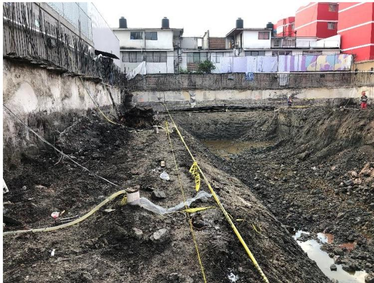
*Figura 36. Excavación y bermas*
