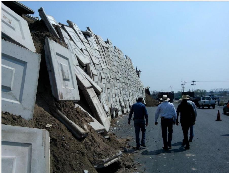
*Ilustración 10. Vista frontal de la falla ocurrida en el muro mecánicamente estabilizado.*
