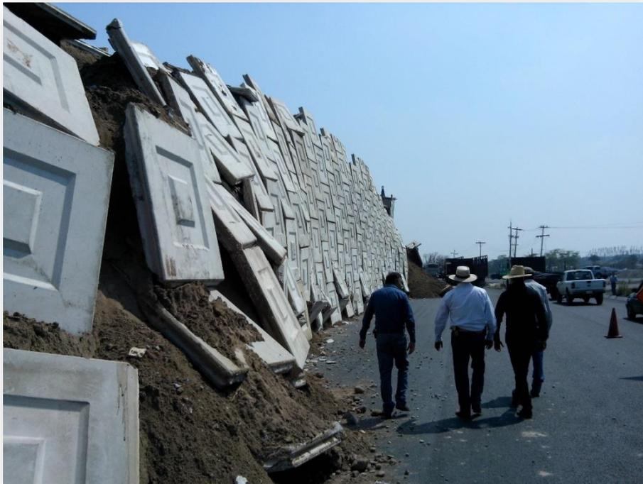
*Ilustración 1. Falla ocurrida en el muro mecánicamente estabilizado "Tamaca".*
