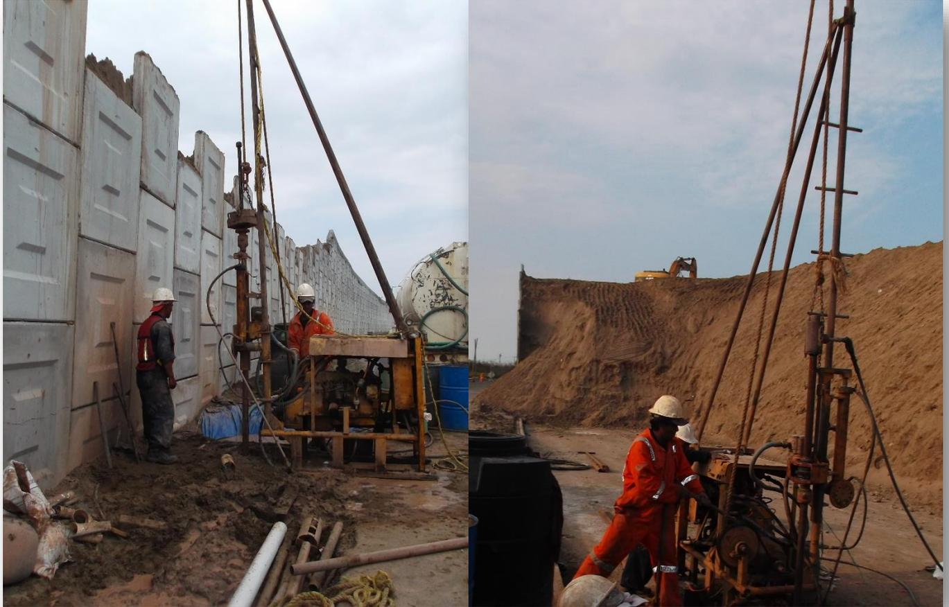
*Ilustración 16. Vista de los sondeos de penetración estándar.*
