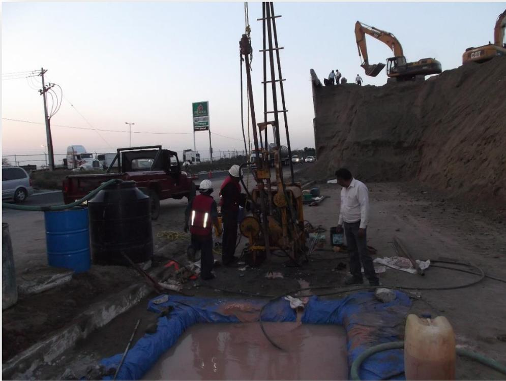
*Ilustración 15. Instalación del equipo de perforación.*
