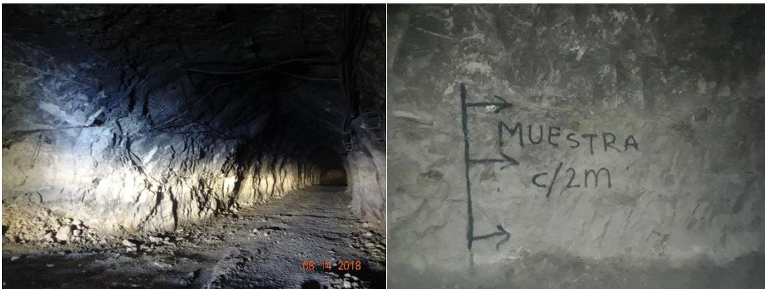
Fotografía 7.- Rampa del acceso 4 SJ 2440. En la fotografía izquierda se observa la longitud del acceso y en la derecha el espaciamiento indicado para las muestras recolectadas en la zona.
