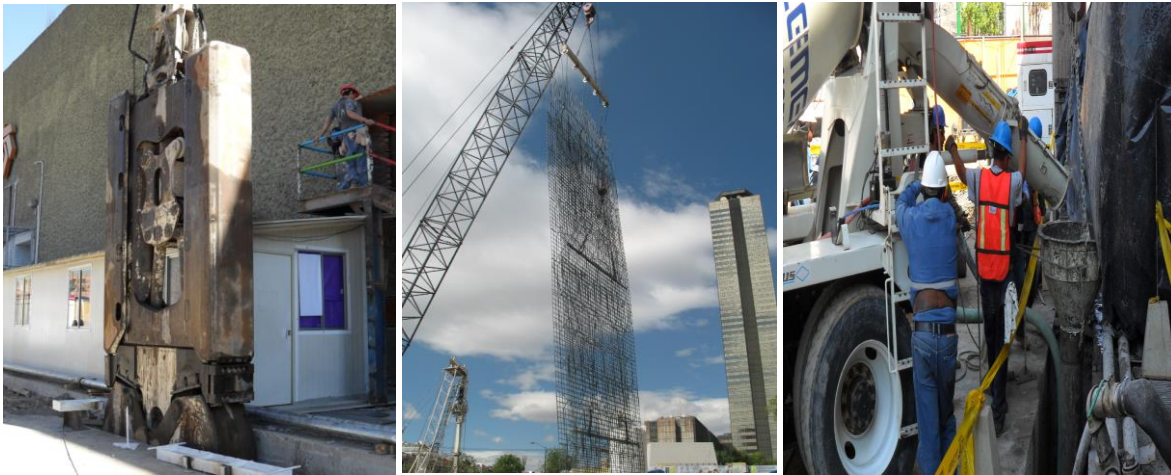
Figura 34. Excavación, maniobrad de izado de acero y colado de muro Milán. Fuente: Cortesía del proyecto Marina 385
