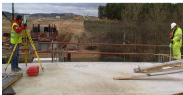
Figura 68. Medición de referencias superficiales. Fuente: http://axisima.com/en-que-consiste-la-nivelacion-topografica/
