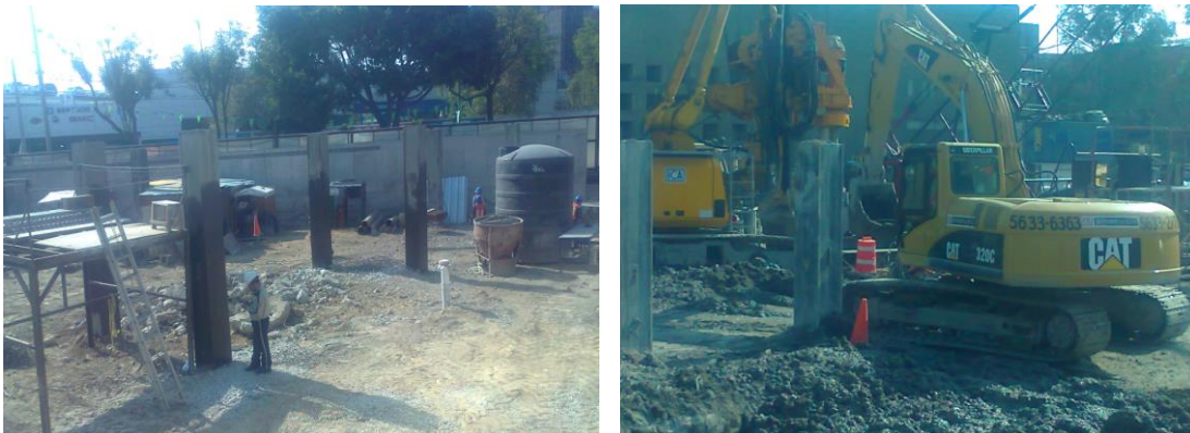
Figura 33. Posición final de columnas metálicas. Fuente: Cortesía del proyecto Marina 385
