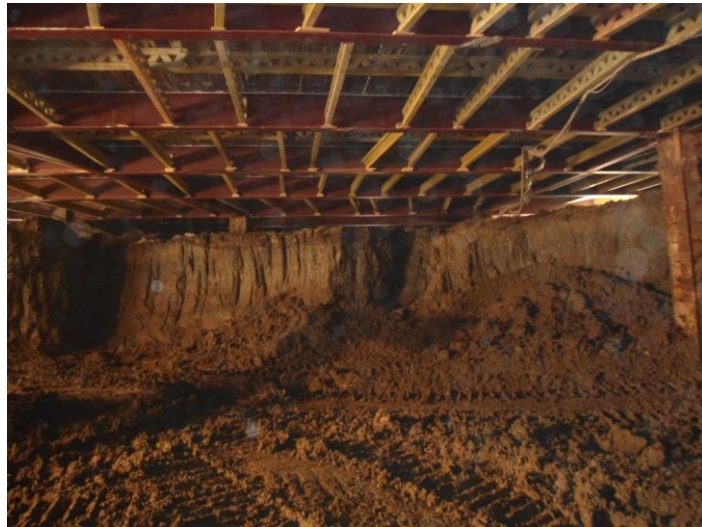
Figura 43. Excavación al nivel -6.0 m. Fuente: Cortesía del proyecto Marina 385
