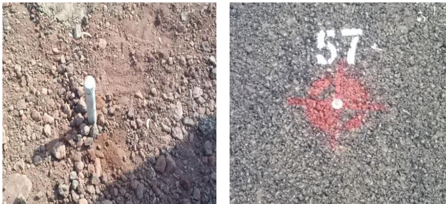
Figura 18. Referencias topográficas instaladas en suelo y pavimento. Fuente: Prueba de carga y precarga para el Nuevo Aeropuerto de Ciudad de México, 2013.
