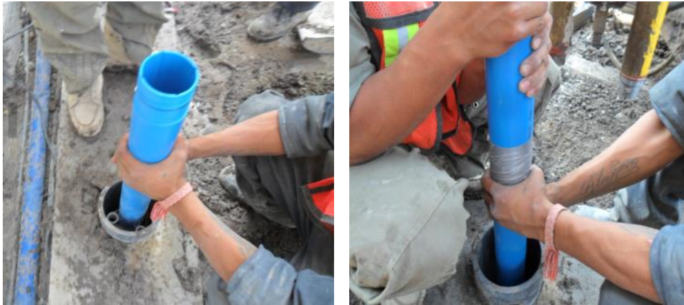
Figura 59. Instalación de tubería y acoplamiento de tubos adicionales. Fuente: Cortesía del proyecto Marina 385
