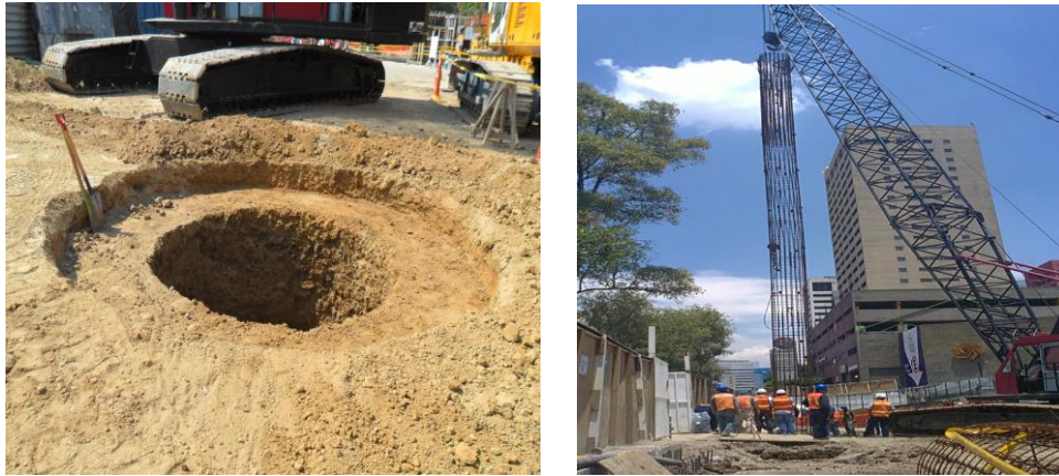
Figura 32. Excavación para construcción de brocal e izado de acero de refuerzo para pila. Fuente: Cortesía del proyecto Marina 385
