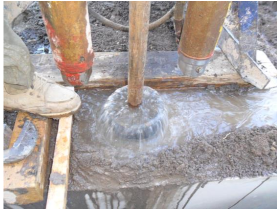
Figura 57. Limpieza de tubería de PVC 6". Fuente: Cortesía del proyecto Marina 385
