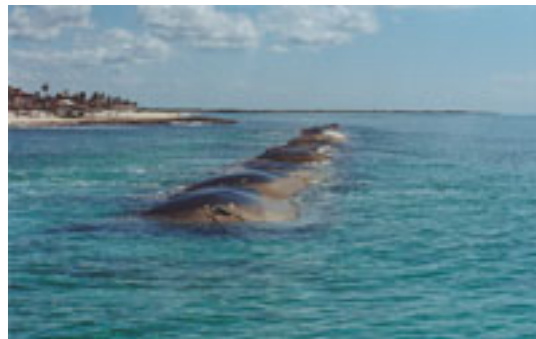
Figura 7-1 Geotubo funcionando como dique.
