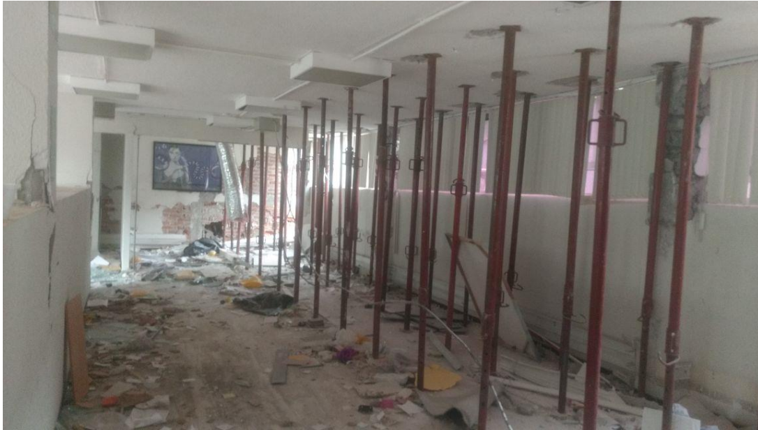
Fig. 7.2 Apuntalamiento del edificio que se ubicaba en la calle Salamanca 66, alcaldía Cuauhtémoc.
