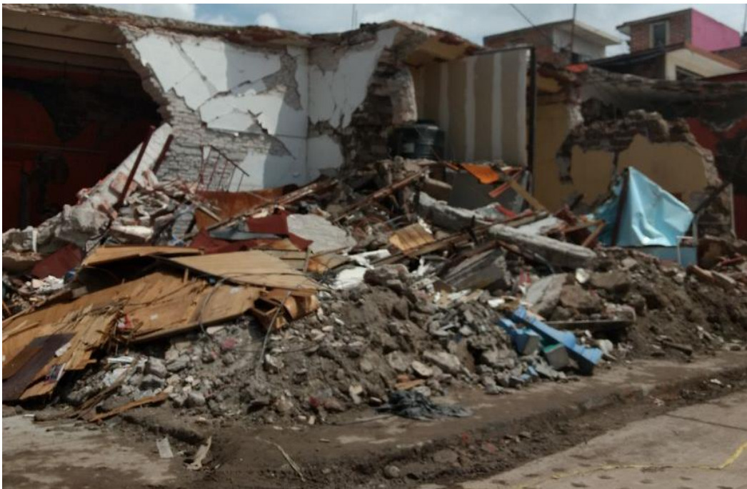
Fig. 7.9 Residuos de la demolición de una vivienda en el estado de Morelos.
