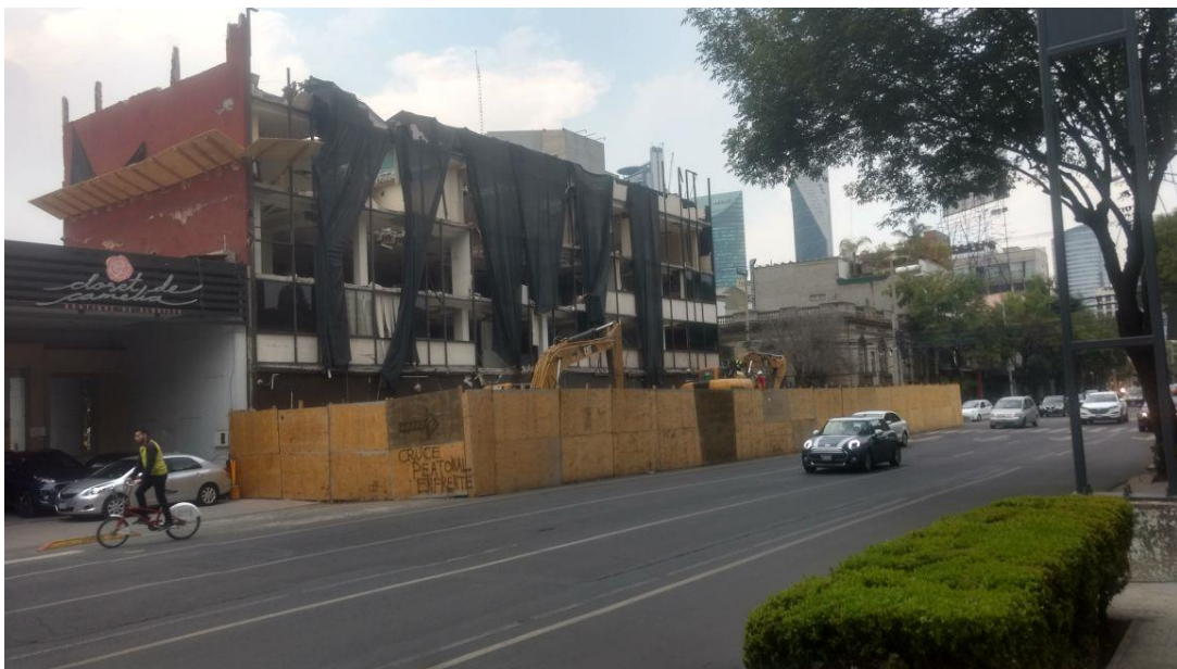
Fig. 7.1 Labores de demolición del edificio que se ubicaba en la calle Salamanca 66, alcaldía Cuauhtémoc.
