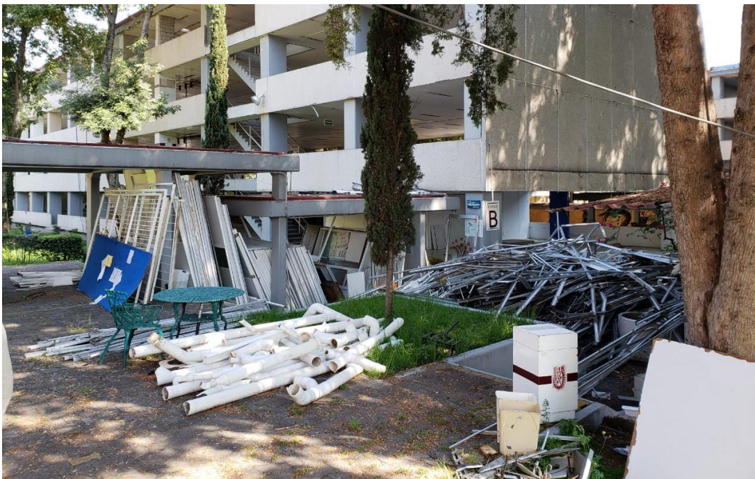
Fig. 7.5 Separación de residuos por tipo (tuberías, marcos de puertas y ventanas).
