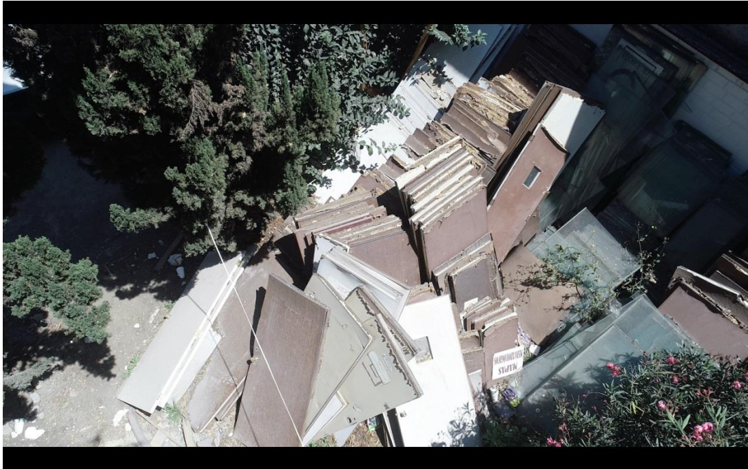
Fig.7.6 Vista área de residuos de puertas y ventanas.
