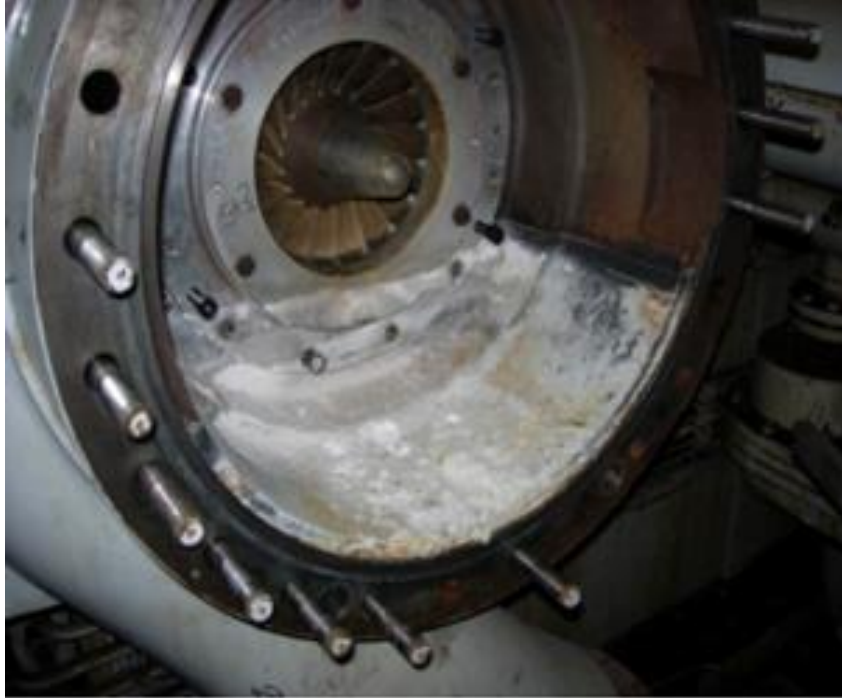
Figura A.4 Suciedad en una etapa de compresión debido a la fuga de agua de mar en el intercambiador, la sal marina puede acumularse en el bastidor del compresor (Zanoli y Astolfi, 2011).
