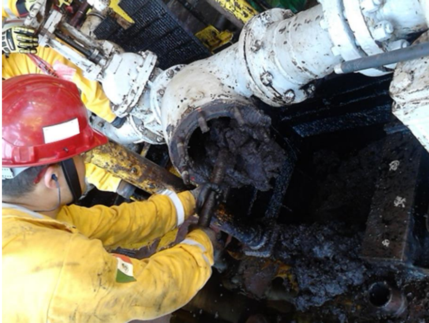
(a) Extracción de «emulsión muerta» posterior a la purga del sistema. El taponamiento de flujo se debe a la alta viscosidad de la emulsión.
