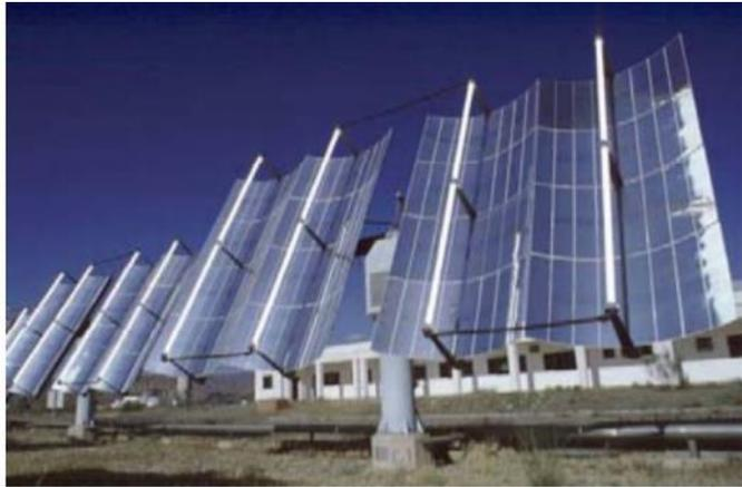
Reactor de concentración media; Concentrador cilindro parabólico (CCP) (Blanco, 2003)
