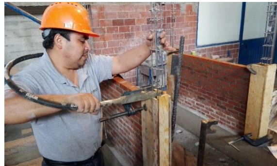
Vibrado de concreto de castillos
