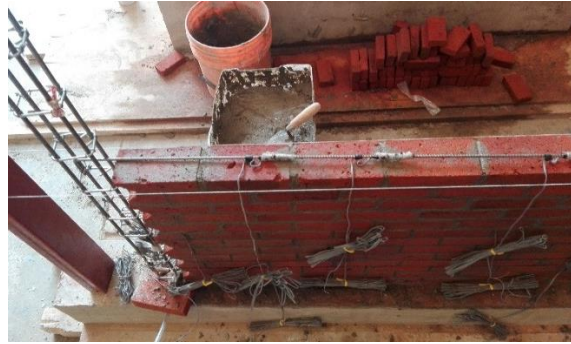
Colocación de acero de refuerzo horizontal
