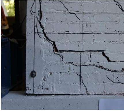
Levantamiento de muro con cimentación
