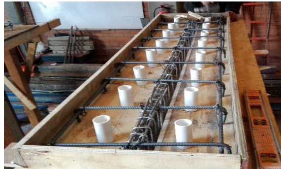
Colocación de armado de losa
