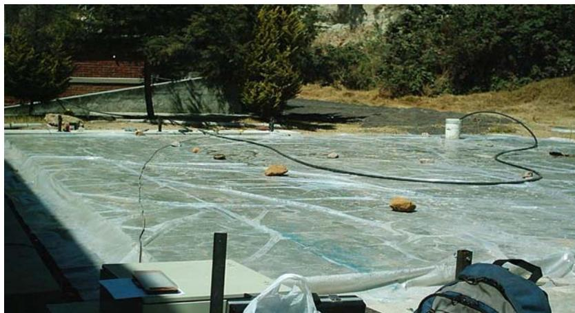
**Figura 2.4** Curado de la losa
