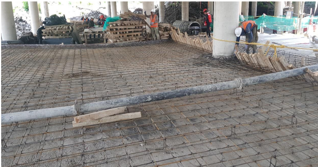
Fig. 4.14 Fotografía del armado de la losa maciza.
