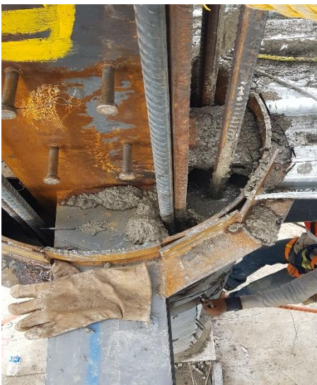
Fig. 4.18 Fotografía de los ángulos para un mejor soporte de la lámina,
