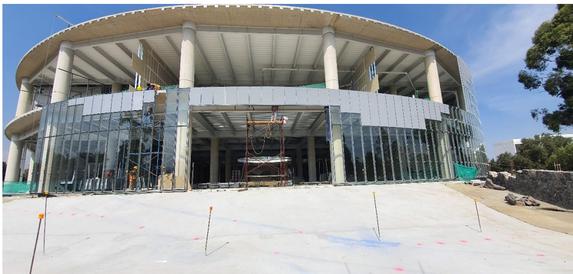
Fig. 6.7 Fotografía tomada en diciembre de 2019 en la cual se refleja el avance actual del proyecto.
