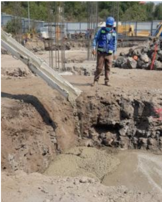
Fig. 2.12 Fotografía del vaciado del concreto de la olla a la zona deseada.
