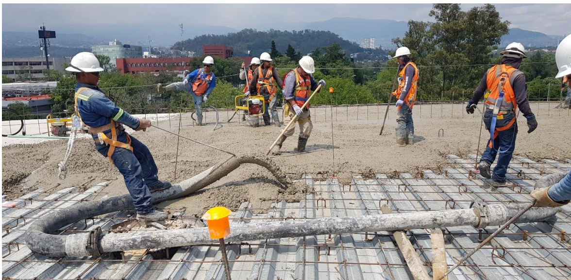
Fig. 4.31 Fotografía de los bomberos controlando la tubería durante un colado en la azotea.
