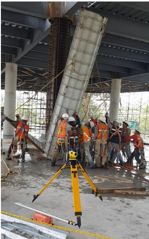
Fig. 3.13 Fotografía del izaje de una media caña.
