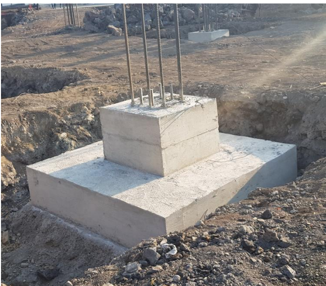
Fig. 2.23 Fotografía de una zapata colada y descimbrada
