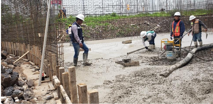
Figura 5.39 Fotografía del colado de la losa fondo del cuarto de máquinas.
