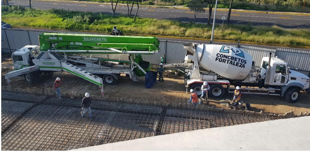
Figura 5.45 Fotografía de la bomba telescópica acomodada en el acceso cercano al circuito vehicular.
