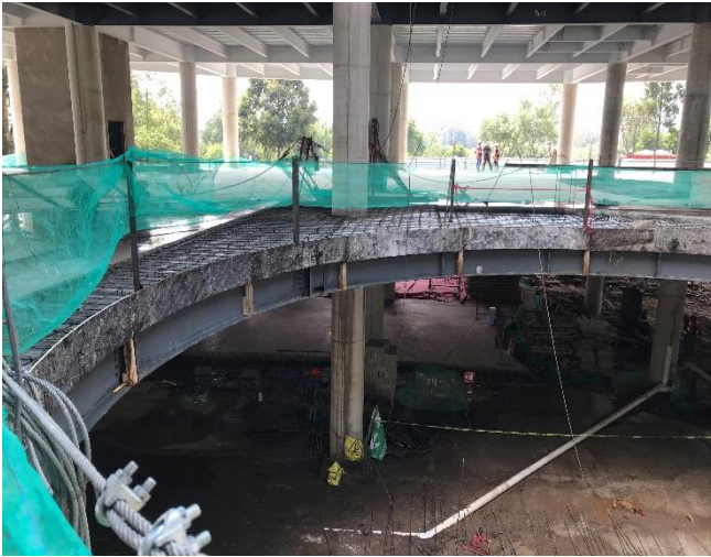
Fig. 4.29 Fotografía de la barrera en el detalle del círculo de la estructura
