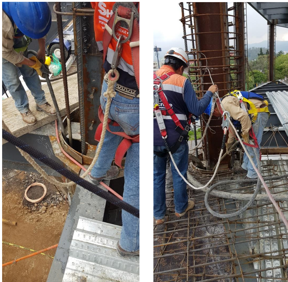
Fig. 3.21. Fotografías en la que se muestra el vibrado del concreto dentro de la cimbra.
