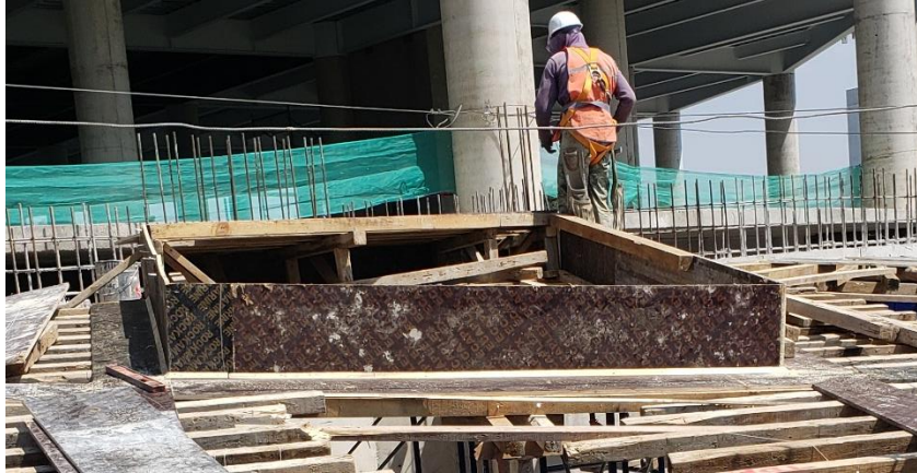
Figura 5.36 Fotografía de los costados de la cimbra en trabes.
