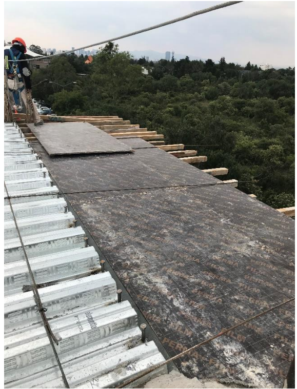
Fig. 4.27 Fotografía del cimbrado de la losa del volado con desmoldante.
