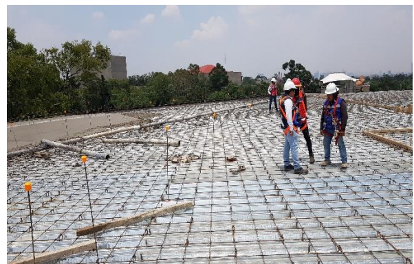
Fig. 4.21 Fotografía del armado en AZ.
