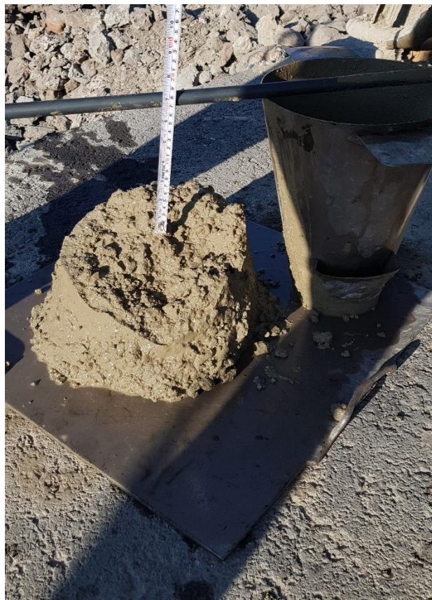
Fig. 2.19 Fotografía de la prueba de revenimiento en campo.
