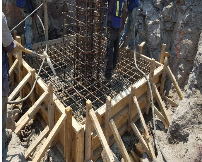
Fig. 2.16 Fotografía de la cimbra de una zapata.
