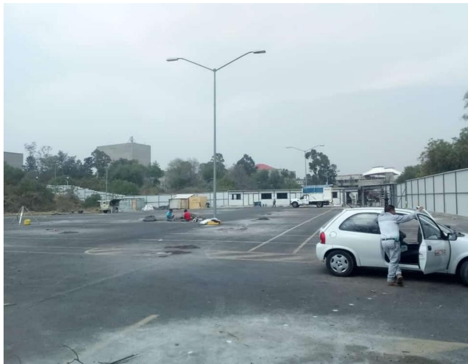
Fig. 2.9 Fotografía del área a trabajar delimitada con tapial blanco.
