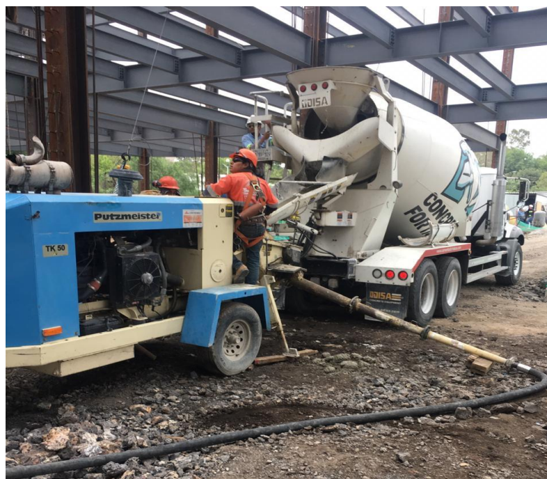
Fig. 3.18 Fotografía de la bomba de concreto lanzado recibiendo el concreto de una olla.
