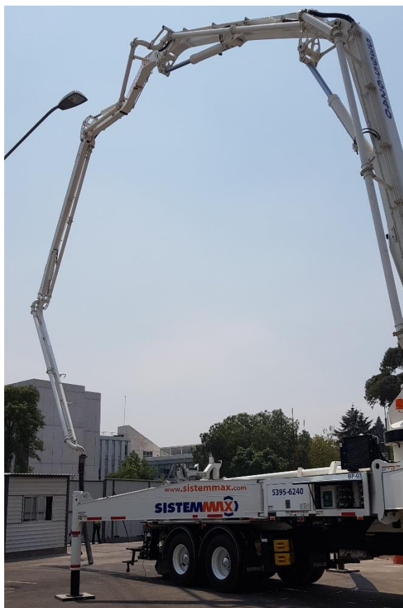
Fig. 2.20 Fotografía de la bomba telescópica desplegada.
