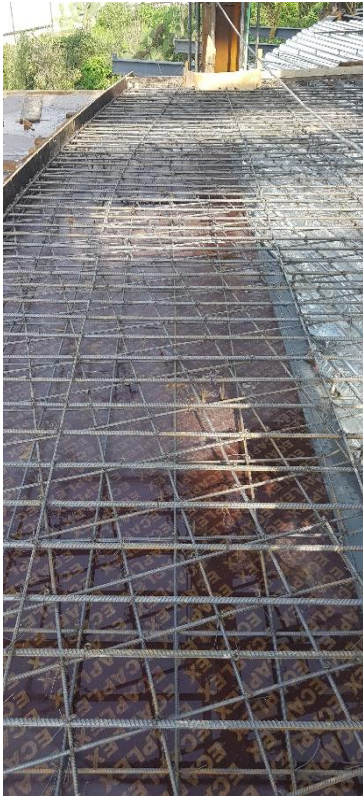
Fig. 4.19 Fotografía del armado del volado en PB.
