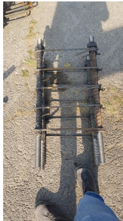
Fig. 2.15 Fotografía del armado de un ancla.
