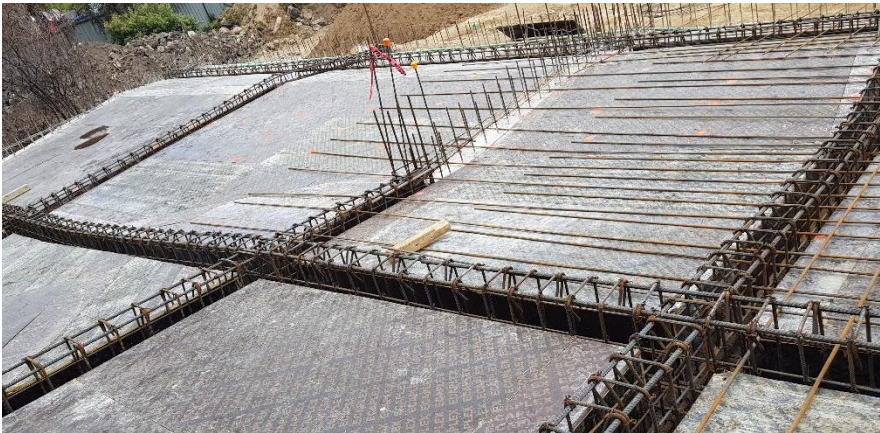
Figura 5.28 Fotografía del tendido de acero para losa tapa.
