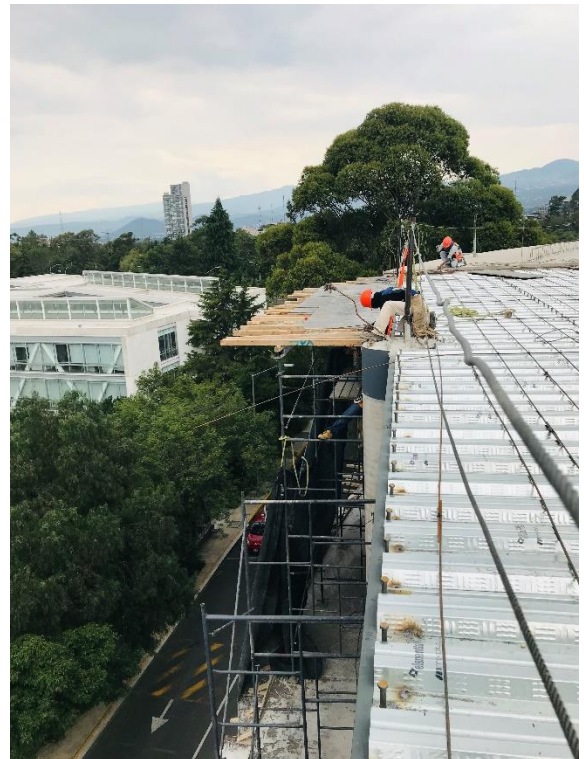
Fig. 4.25 Fotografía de la obra falsa en volado.
