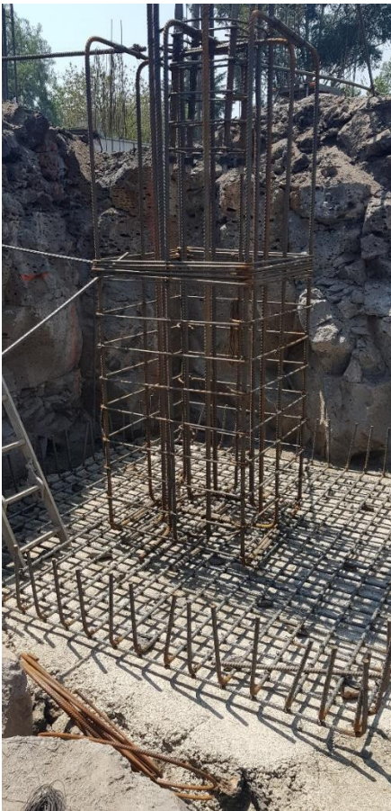
Fig. 2.14 Fotografía del armado de la zapata 16
