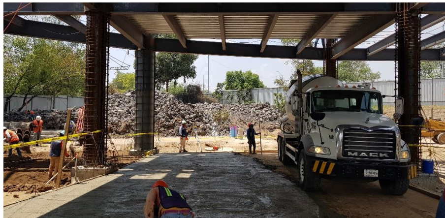
Fig. 4.13 Fotografía del colado de la plantilla.
