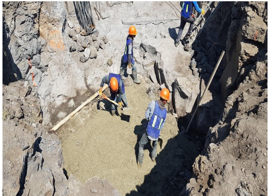
Fig. 2.13 Fotografía del extendido y colocación de roca basáltica para el concreto ciclópeo
