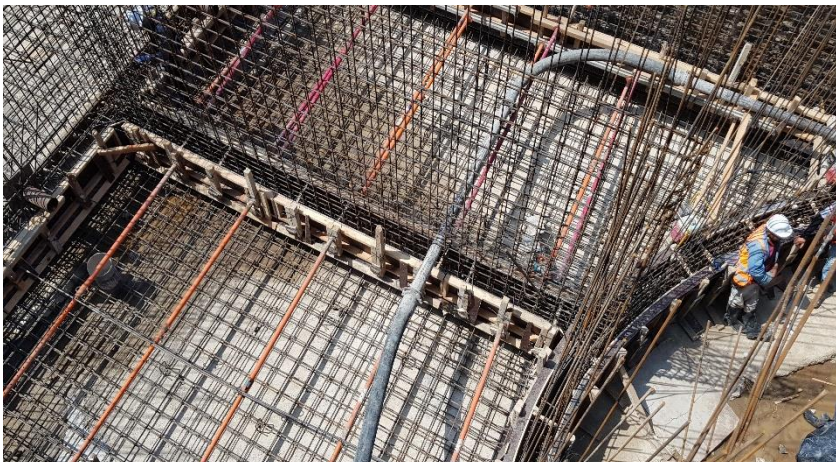
Figura 5.31 Fotografía en elevación de la cimbra en cisterna.
