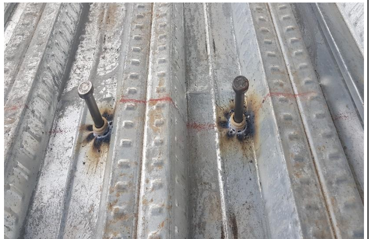
Fig. 4.17 Fotografía de pernos y ferrul ya colocados en la losacero.
