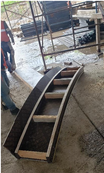
Figura 5.30 Fotografía de un módulo de cimbra curva.
