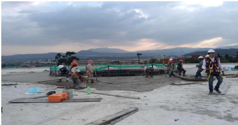
4.37 Fotografía del último colado de losa
