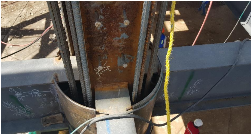
Fig. 3.17 Fotografía tomada mostrando el espacio que quedaba para colar la columna.
