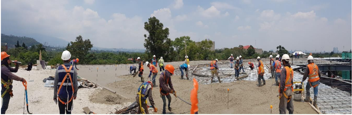
Fig. 4.32 Fotografía panorámica durante un colado en la azotea, se denota la cantidad de gente que se ve involucrada en el proceso.
