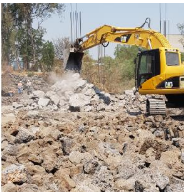
Fig. 2.11 Fotografía de la excavadora acopiando la roca producto de la excavación.
