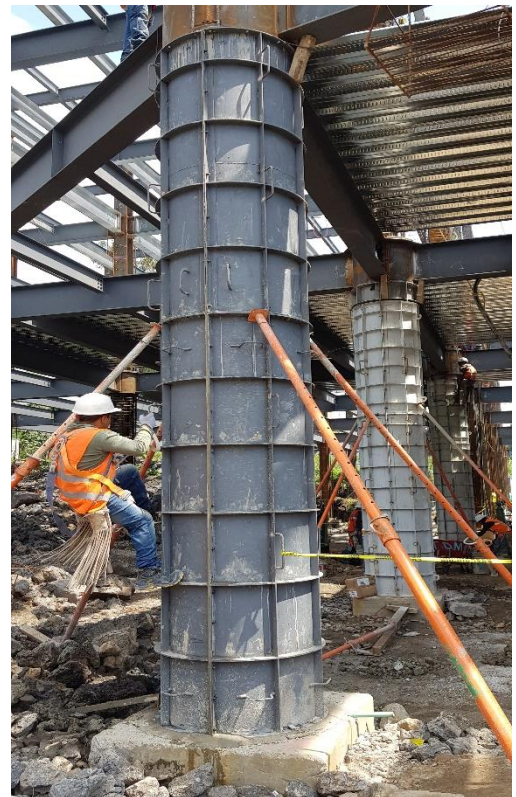
Fig. 3.14 Fotografía del apuntalamiento de la cimbra.
