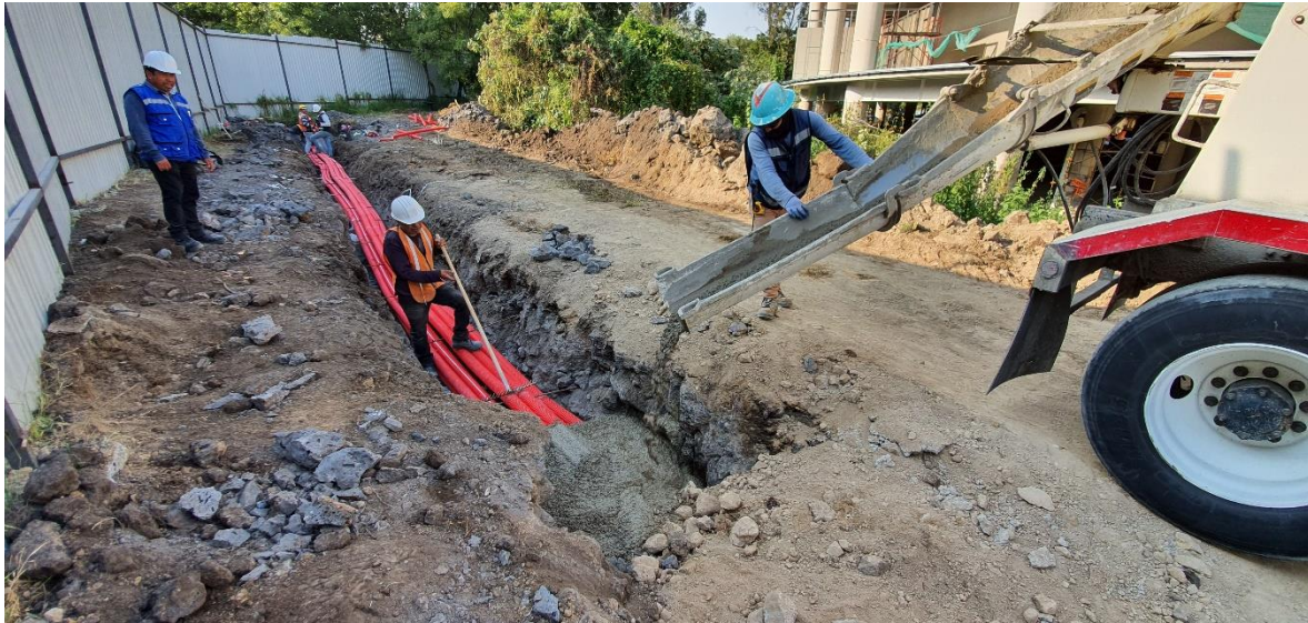
Fig. 6.5. Colado del encofrado para tubería de media tensión en sepa adecuada para la colocación de dicha tubería,
