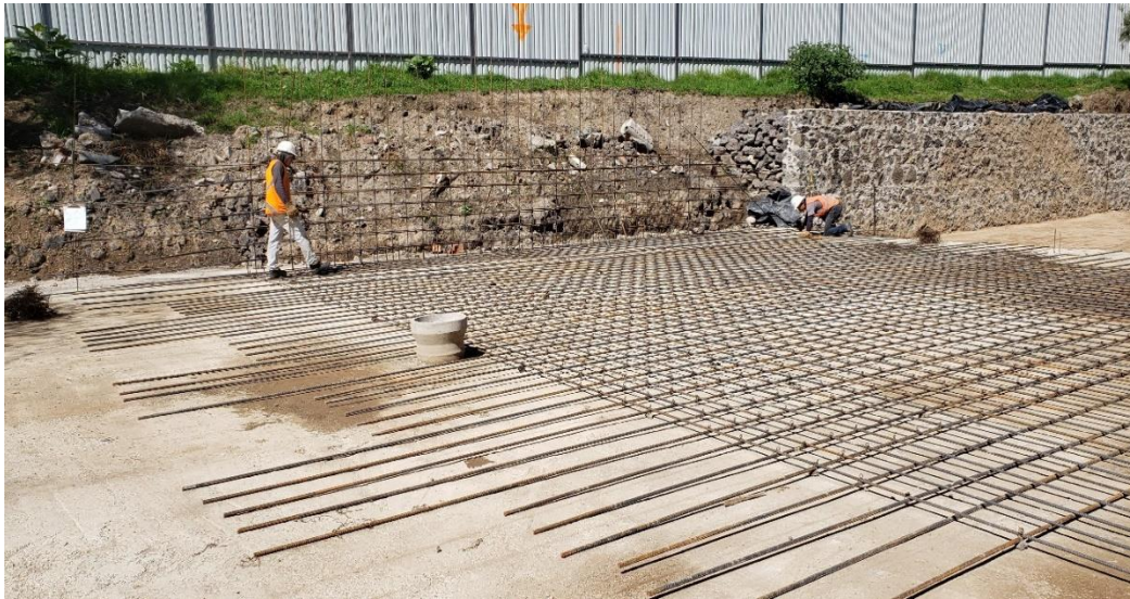
Figura 5.21 Fotografía en la que se denota la existencia de la plantilla y el inicio del armado de la losa fondo del cuarto de máquinas y cisterna.
