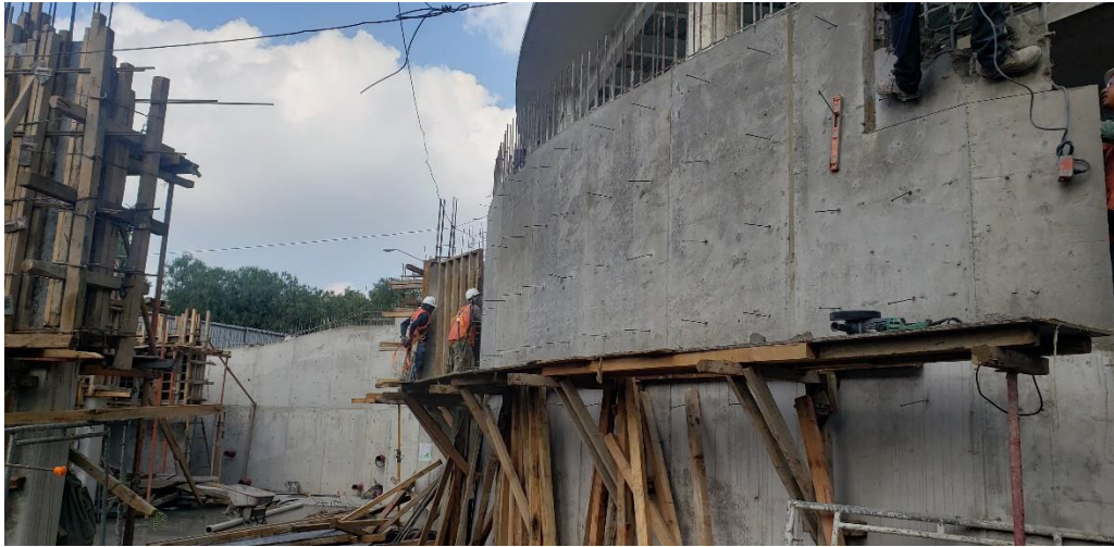
Figura 5.44 Fotografía del muro curvo del cuarto de máquinas siendo descimbrado.
