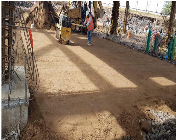
Fig. 4.11 Fotografía de la compactación del tepetate.
