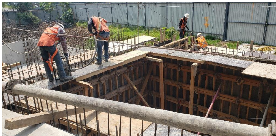
Figura 5.43. Fotografía del segundo trepado del muro de cisterna.
