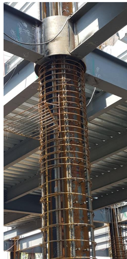
Fig. 3.11 Fotografía del armado transversal denotando la separación de los estribos.
