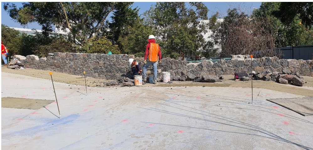
Fig. 6.6. Construcción de pretil de basalto de 70 cm de altura.
