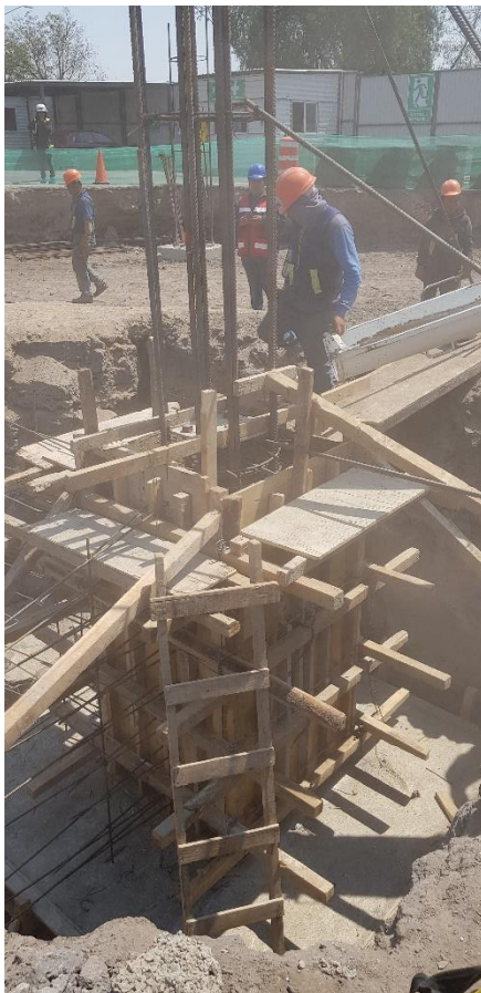
Fig. 2.17 Fotografía de la cimbra de un dado con plataforma de trabajo.
