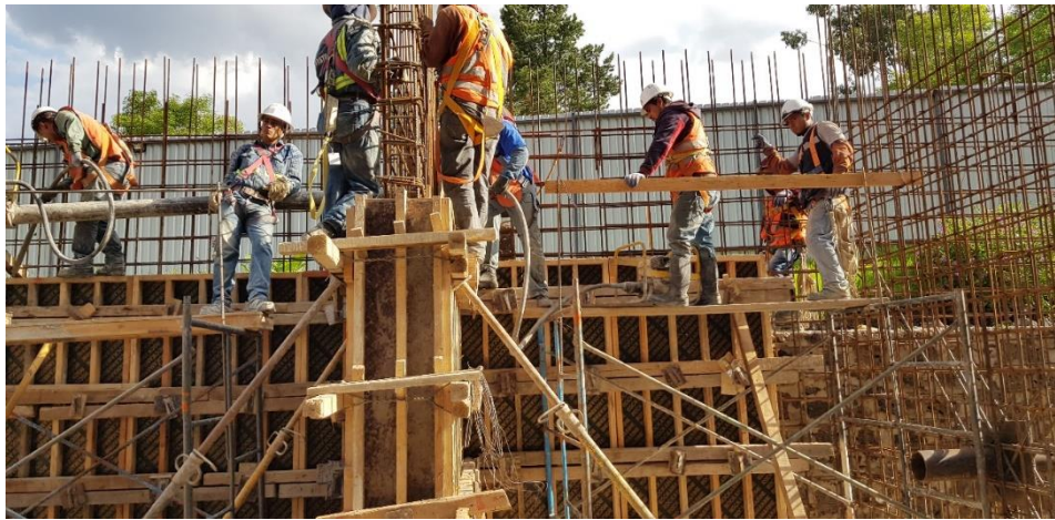
Figura 5.42. Fotografía durante el colado del primer trepado de los muros en cuarto de máquinas.
