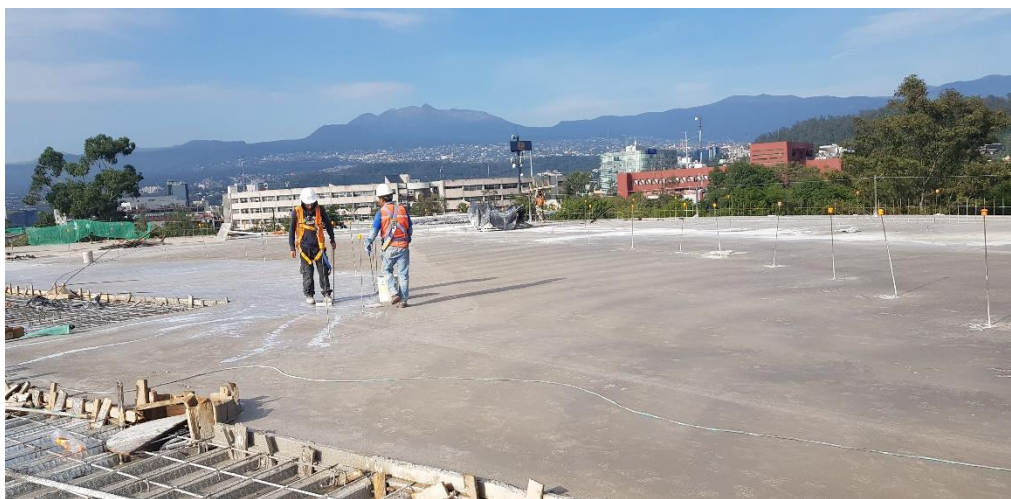
Fig. 4.35 Fotografía del curado de la losa de nivel AZ con curacreto.
