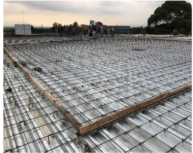
Fig. 4.30 Fotografía de la frontera de un colado en la azotea.
