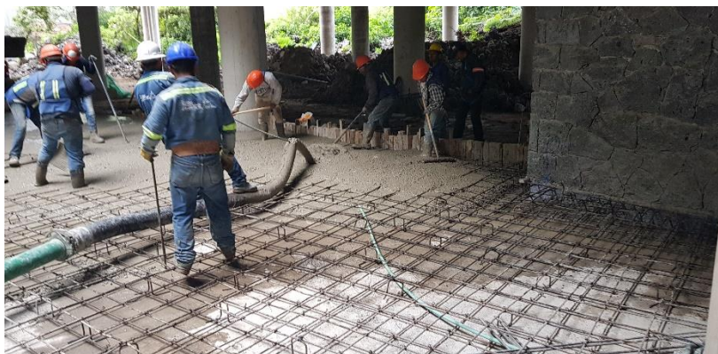
Fig. 4.15 Fotografía del colado de losa maciza en el cual se denota las tuberías ahogadas y la frontera de colado.
