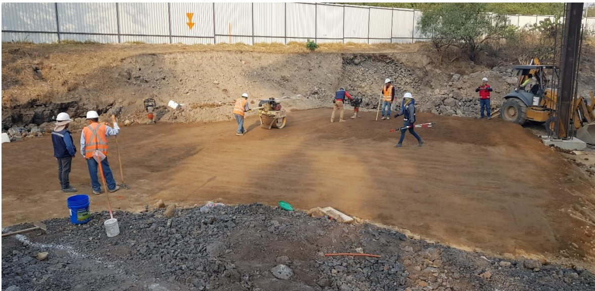
Figura 5.20 Fotografía que muestra el mejoramiento del terreno donde se desplantará del cuarto de máquinas y cisterna
