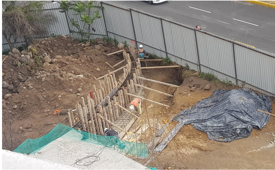
Fig. 6.3. Fotografía de la cimbra de la cimentación para el pretil de basalto.
