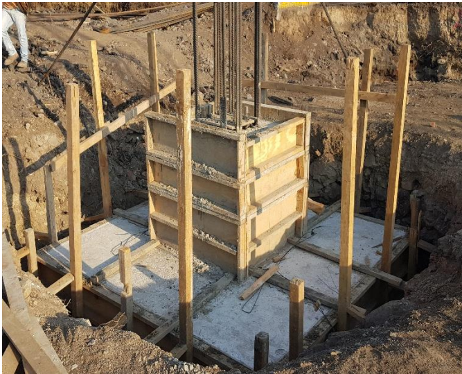
Fig. 2.22 Fotografía de una zapata colada y cimbrada.
