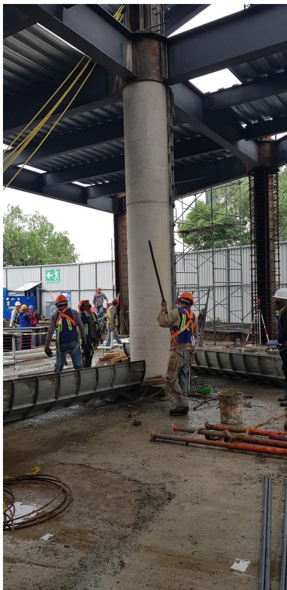
Fig. 3.24. Fotografía del descimbrado de una columna en N-1.
