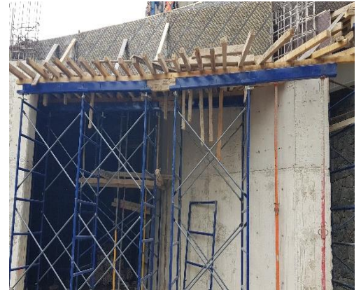
Figura 5.34 Fotografía de los andamios de carga
