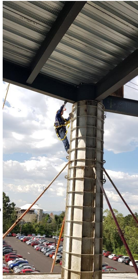
Fig. 3.12 Fotografía de un topógrafo revisando el plomo de la cimbra.
