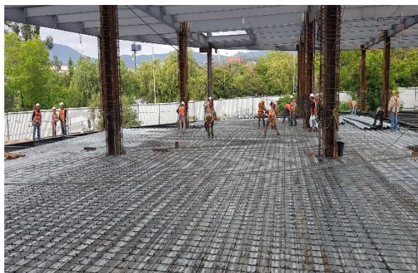
Fig. 4.20 Fotografía del armado en N1.
