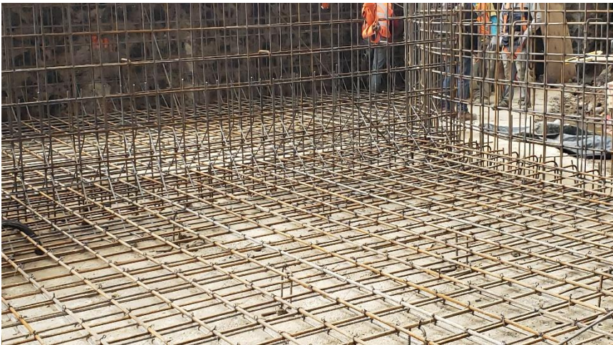
Figura 5.22. Fotografía que muestra el armado de la losa fondo de la cisterna.
