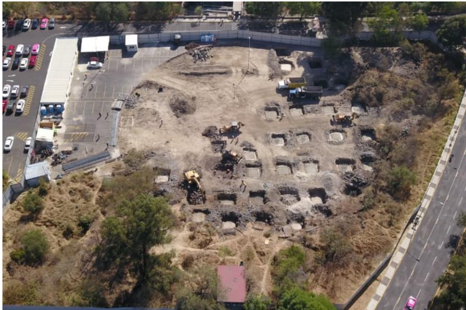
Fig. 2.10 Fotografía aérea del avance de la excavación, tomada por un dron.
