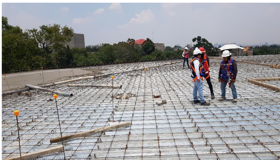
Fig. 4.34 Varillas con capuchones naranjas, utilizadas para no perder de vista el parte aguas y tener con ellas referencias del nivel en esas zonas.
