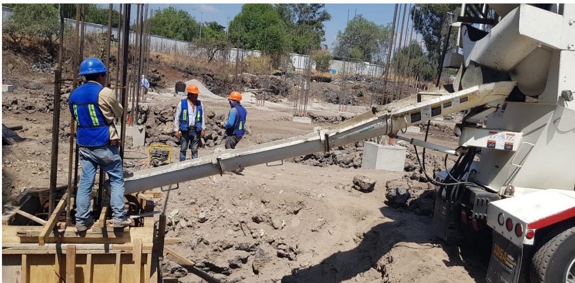
Fig. 2.21 Fotografía de la olla con el doble canalón para mayor alcance de tiro directo.
