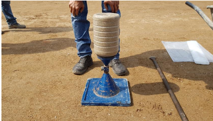
Fig. 4.12 Fotografía de la prueba de campo para obtener el grado de compactación
