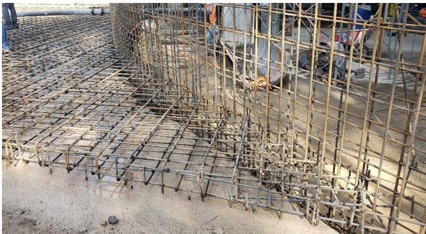
Figura 5.23. Fotografía que muestra el armado de la losa fondo del cuarto de máquinas.
