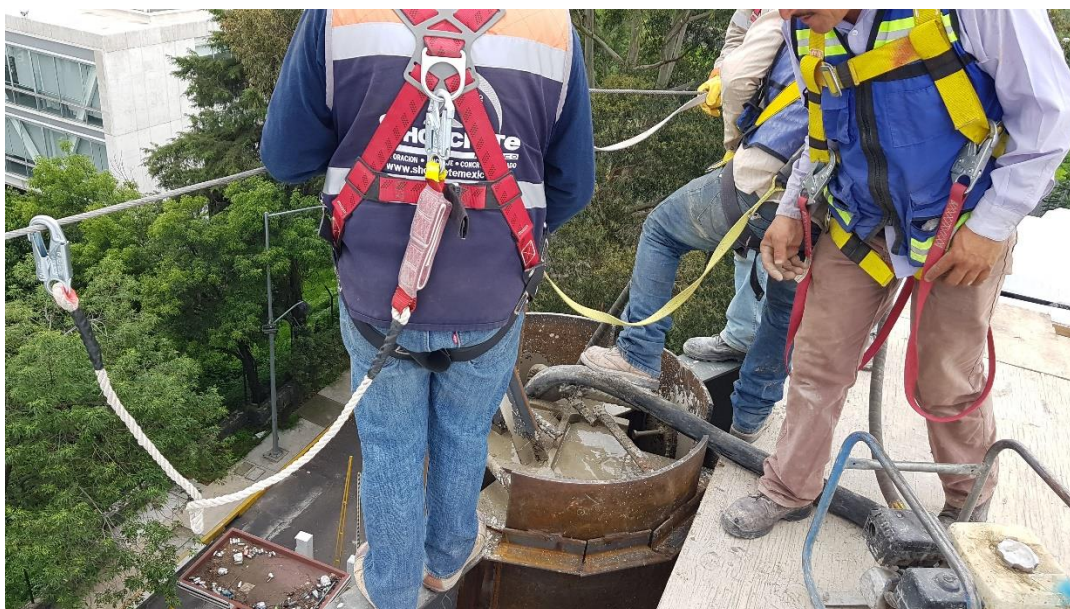
Fig. 3.23. Fotografías en la que se muestra el colado de una columna en nivel azotea, denotando el uso de arnés de seguridad anclado a la línea de vida.
