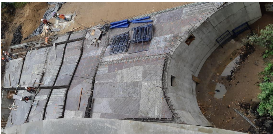
Figura 5.37 Fotografía de la cimbra en losa tapa.
