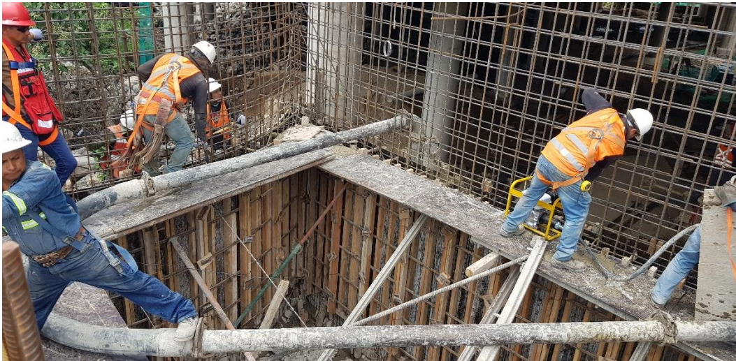
Figura 5.40 Colado del primer trepado en muros de la cisterna.
