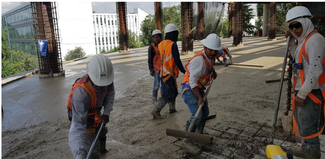
Fig. 4.33 Trabajadores equipados con jaladores para extender el concreto durante un colado en N1
