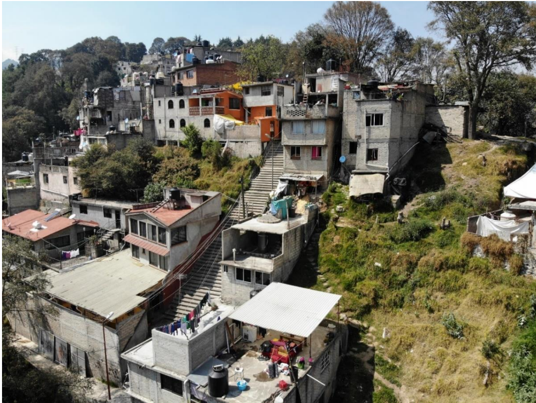
Fig. 5.15 Vista lateral de la ladera (SW-NE). Se nota la interacción con el entorno, un terreno escarpado con barrancas marcadas.
