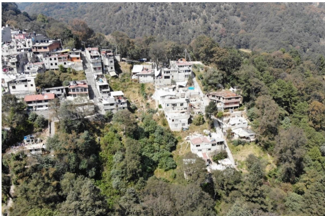
Fig. 5.16 Vista lateral de la ladera (SW-NE). La constante interacción antrópica con esta ladera ha ocasionado la incorporación artificial de humedad e incremento de peso en ella.
