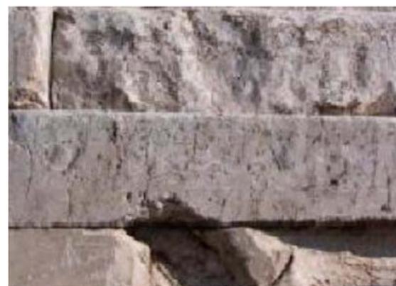
Fig. II.1.2 Capas de piedra cortada y sin mortero para permitir deslizamiento de la Tumba de Ciro el Grande. (Bayraktar, 2012)
