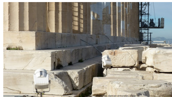
Fig. II.1.5 Capas de piedra cortada y sin mortero para permitir deslizamiento del Partenón. (flickr.com, 2016)
