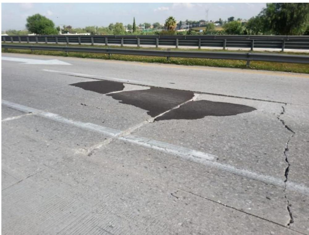
**Ilustración 6. Falla en el pavimento de la Autopista Arco Norte. Fuente: tomada en sitio.**
