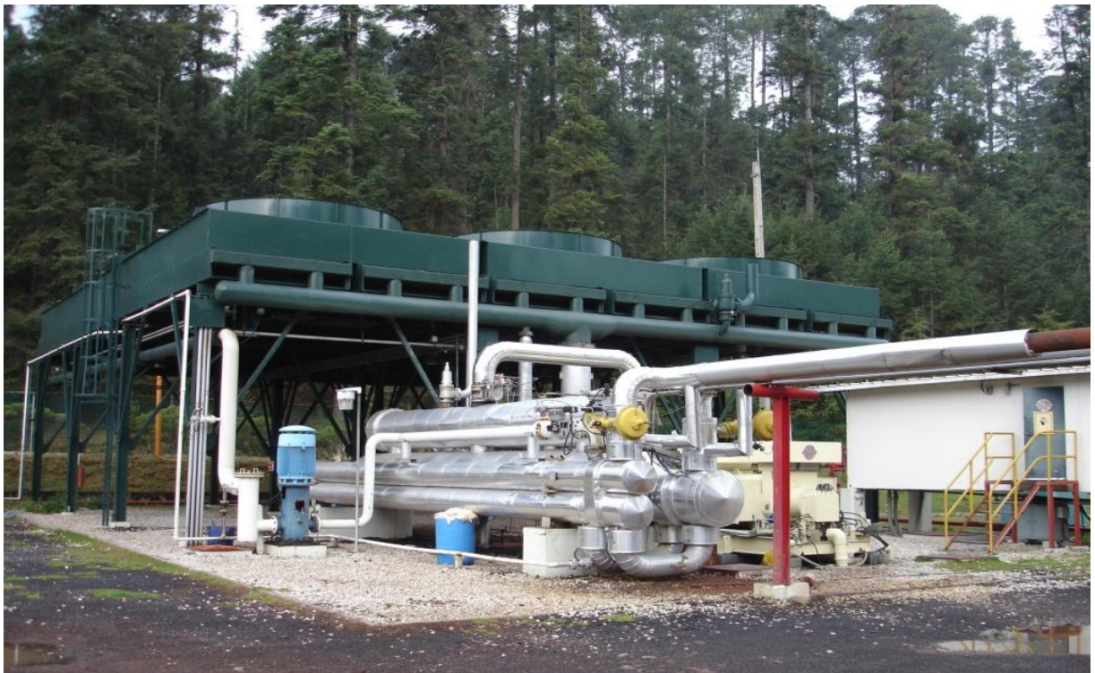
Figura 3.8 Esquema de funcionamiento de una planta de ciclo Binario, (Los Azufres, Michoacán)
