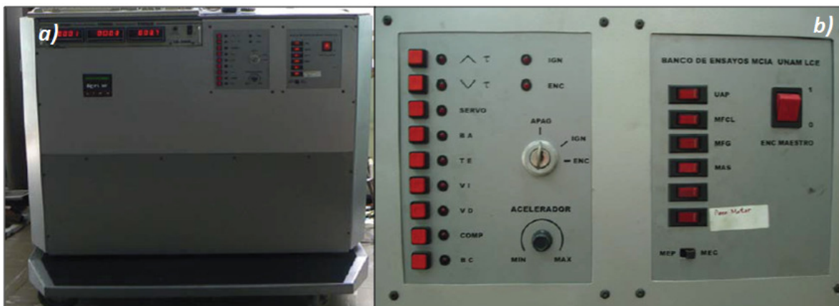
Figura 3.16. a) Consola de mando, b) Panel de control.
