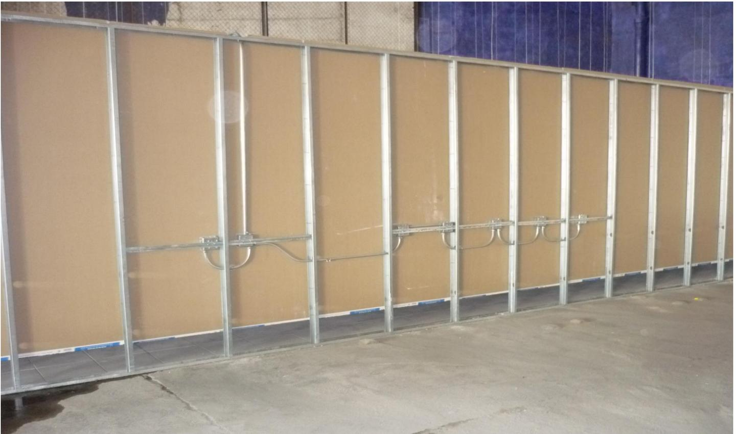
Figura.-61 Estos muros de tabla roca fueron contruidos para la tienda escuela, aquí se puede observar la canalización de contactos.
