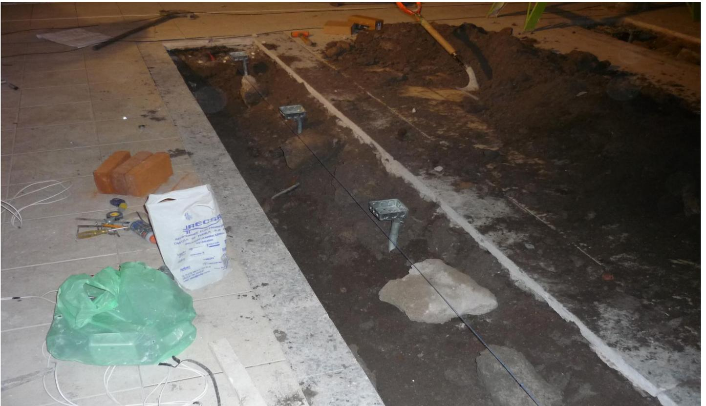
Figura.-69 Colocación de tubería para contactos de piso.
