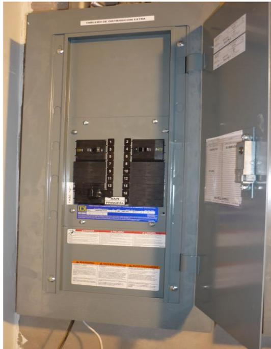
Figura.-77 Tablero de interruptores generales.
