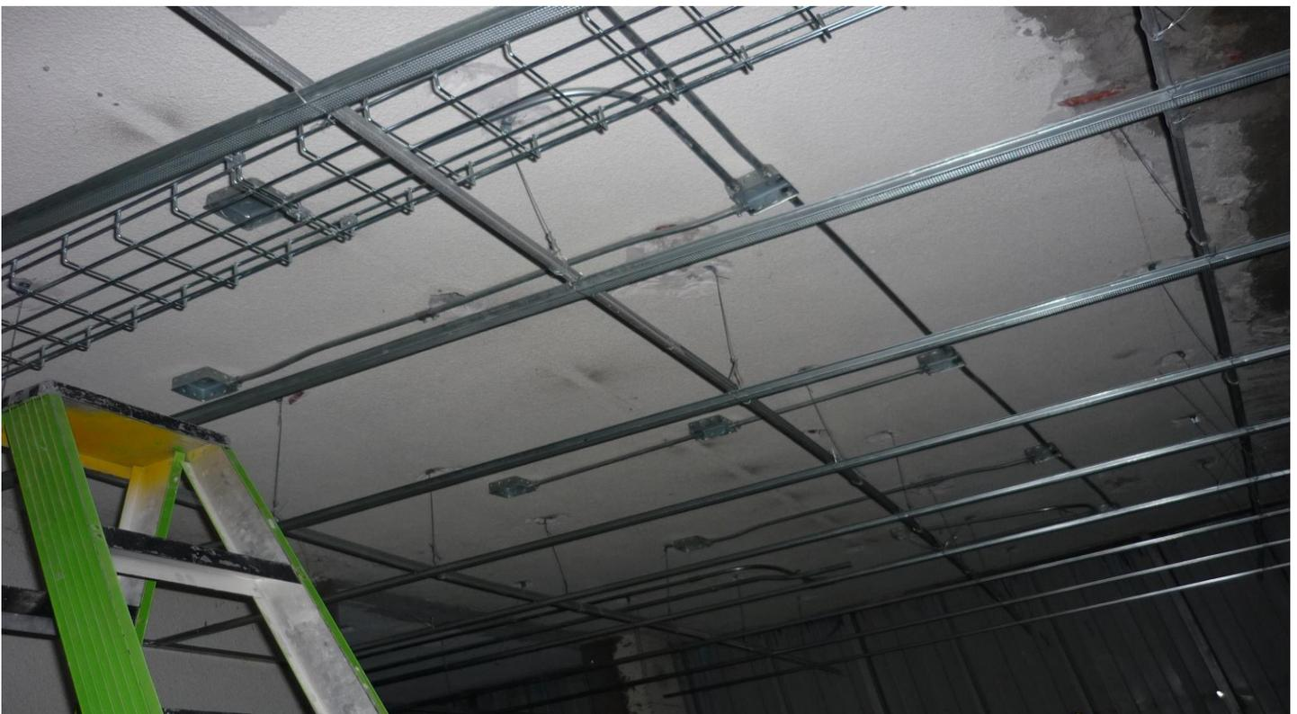
Figura.-62 En esta imagen se observan las salidas de alumbrado en la zona de capacitación.
