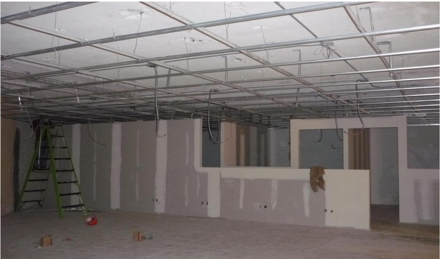
Figura.-73 Cableado de alumbrado y contactos en sala de capacitación.
