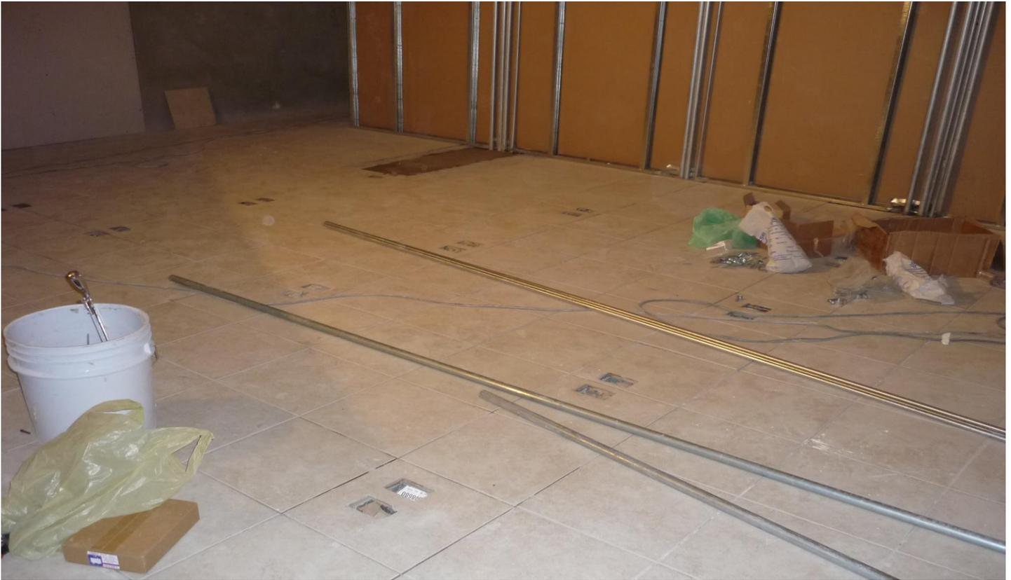
Figura.-64 Aquí podemos observar la colocación de contactos normales de piso ubicados en oficinas EDM.
