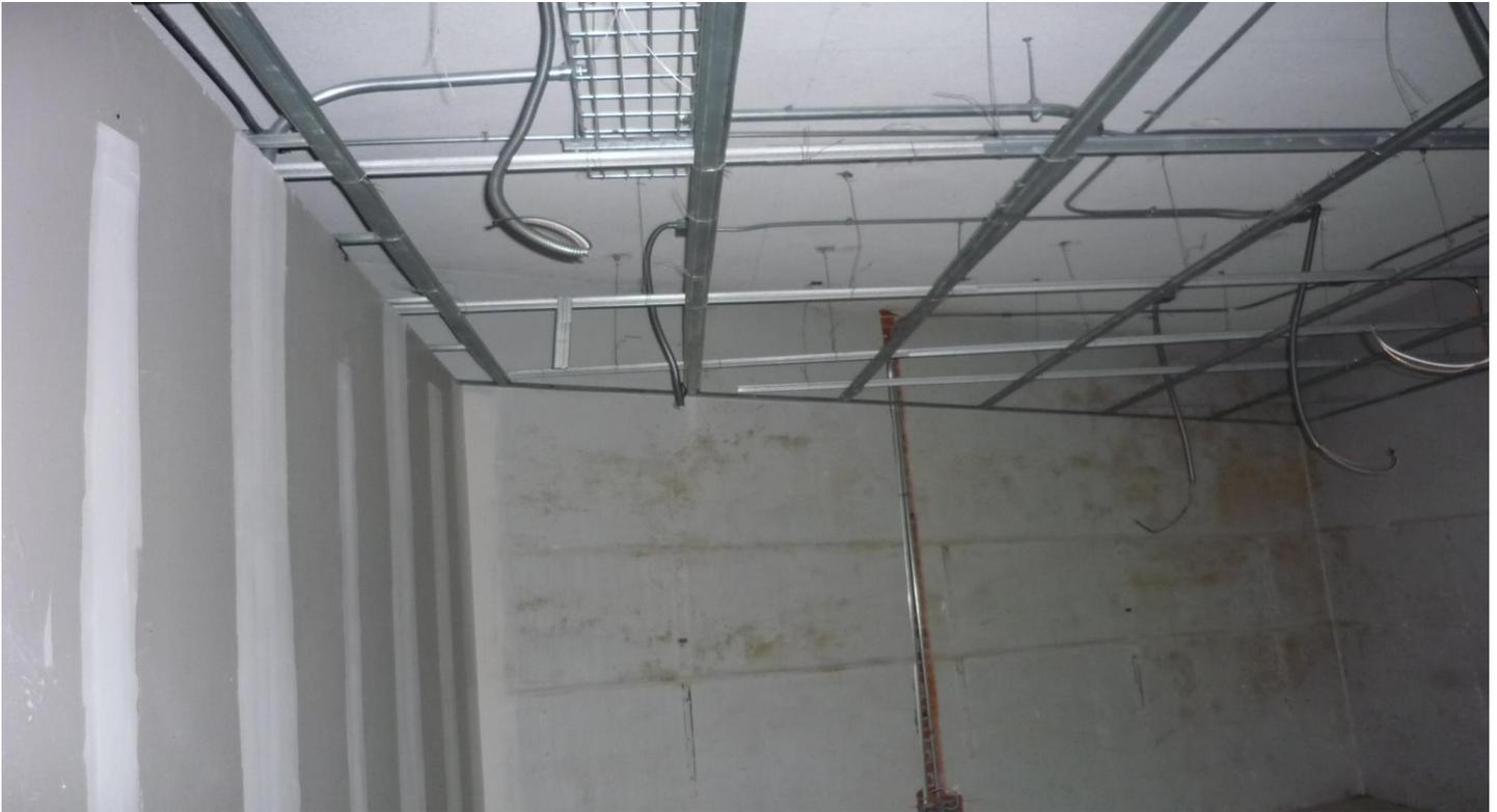
Figura.-72 Cableado de alumbrado en sala de capacitación primer piso.
