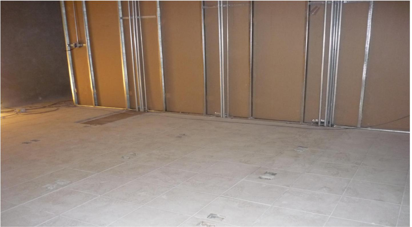
Figura.-70 Contactos de piso en sala de capacitación.
