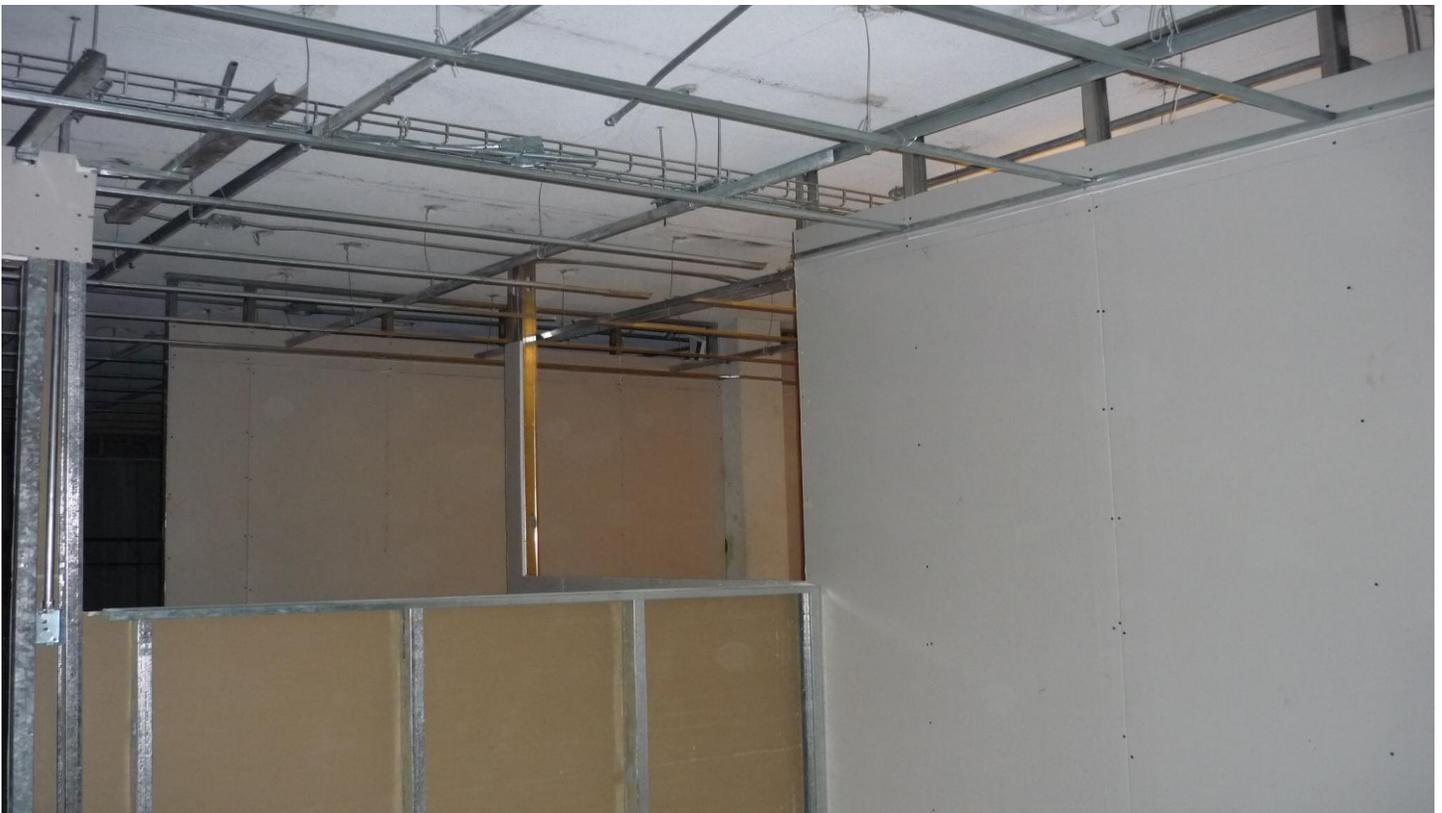
Figura.-65 En esta imagen se puede observar la canalización de las oficinas individuales.
