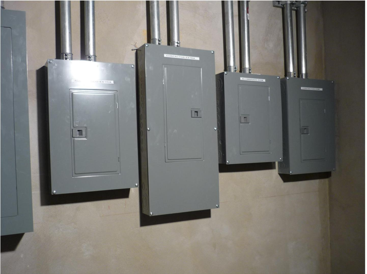
Figura.-81 Arreglo de tableros en cuarto eléctrico.
