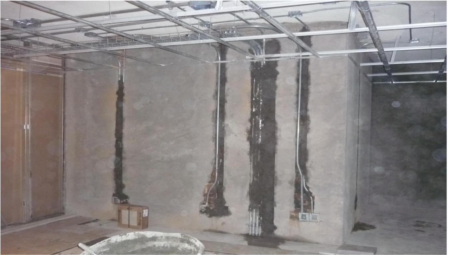
Figura.-63 Aquí podemos observar las salidas de contactos normales colocados en muro de tabicón, para empotrar es necesario ranurar y después resanar, el acabado final será pasta texturizada.
