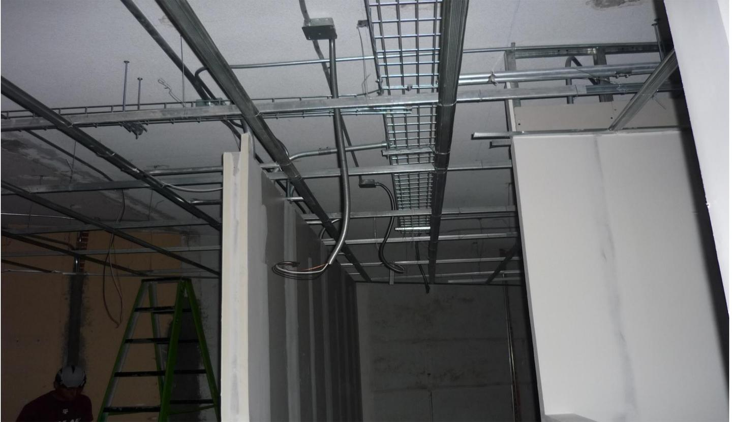
Figura.-71 Cableado de alumbrado en pasillos.
