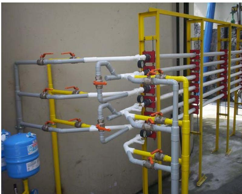
**Figura 0-3. Módulos tubulares de membranas**
