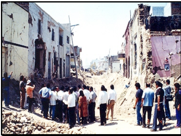
Figura II.1. Daños ocasionados a viviendas como consecuencias de las explosiones (SIAPA, 1999)
