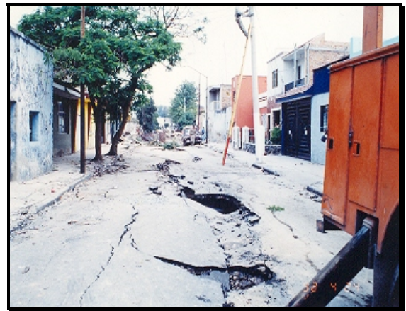
Figura II.2. Daños ocasionados a calles como consecuencia de las explosiones (SIAPA, 1999)
