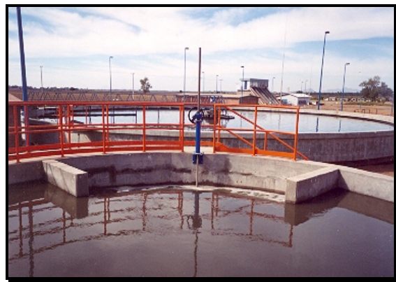
Figura V.23. Primer plano de una de las compuertas deslizantes, la cual controla el gasto alimentado al sedimentador que se observa en la parte posterior de la imagen
