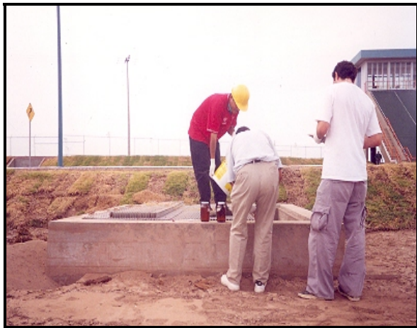
Figura V.13. Muestreo compuesto del agua residual tratada (registro ubicado en la salida de la cámara de contacto de cloro)
