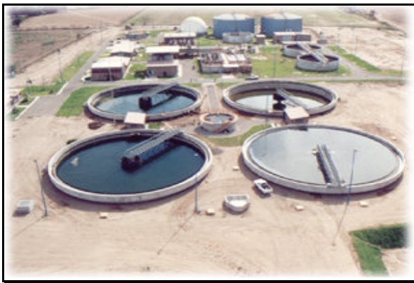
Figura V.22. Vista panorámica de la cámara de repartición de gasto y los cuatro sedimentadores
