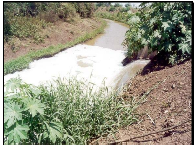
Figura V.14. Descarga del agua residual tratada, al “dren” principal Cedritos
