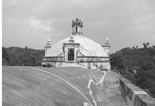
(b) Extradós de la bóveda de Hueyapan
