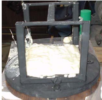
Figura 2.6 Aplicación de espuma aislante
