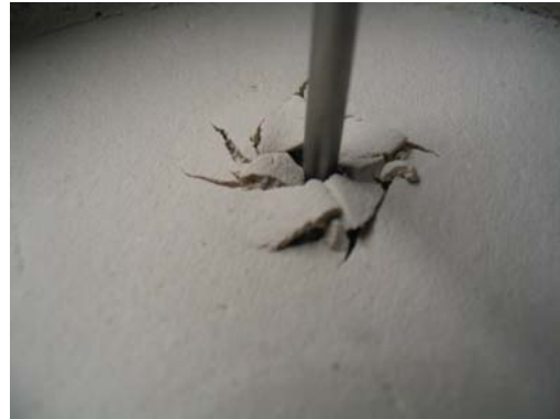
(b) Zona de falla durante el ensayo
