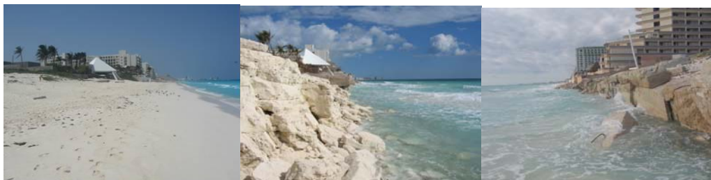
Figura 5. 30. (a)Antes del Huracán Wilma, (b) Después del Huracán Wilma, (c) Ubicación del Hotel Cancún Palace después de que pasó el Huracán Wilma
