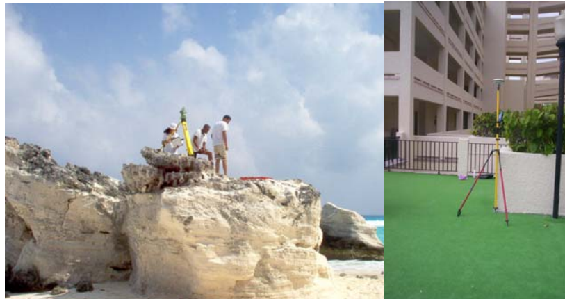
Figura 2. 6. Utilización de la estación total y GPS
