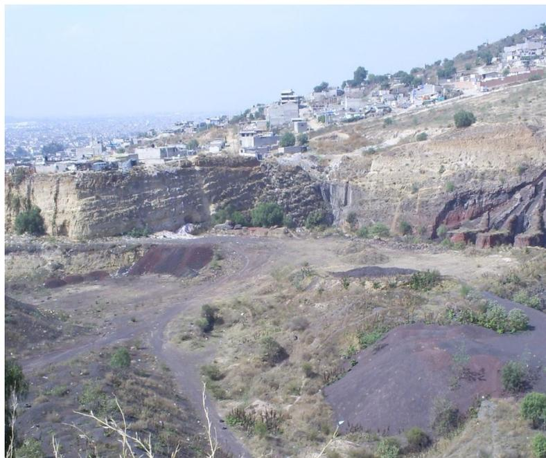
Foto V-3. Muestra los cortes de la mina y que puede provocar riesgos de deslizamientos y derrumbes debido a los asentamientos humanos.
