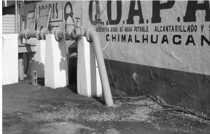
Foto II-1. Pozo profundo de agua potable con bomba submarina a 150.00 m de profundidad, ubicado en Av. Bordo Xochiaca, esq. Av. Del peñón, municipio de Chimalhuacán.
