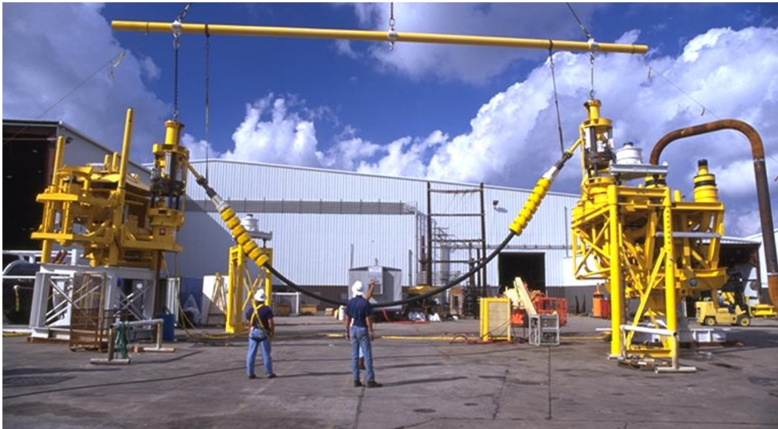
Fig. V. 16. Instalación de un jumper flexible.
