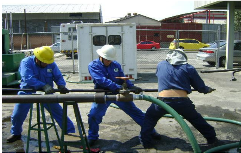
Fig. 4.18. Pruebas de anclaje en tubería de 2 7/8”.
