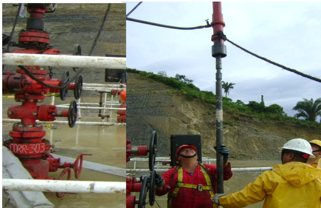
Fig. 4.22. Se habilita EDF-Jet para ser bajado e instalado en la TP, con previa instalación del ancla mecánica.
