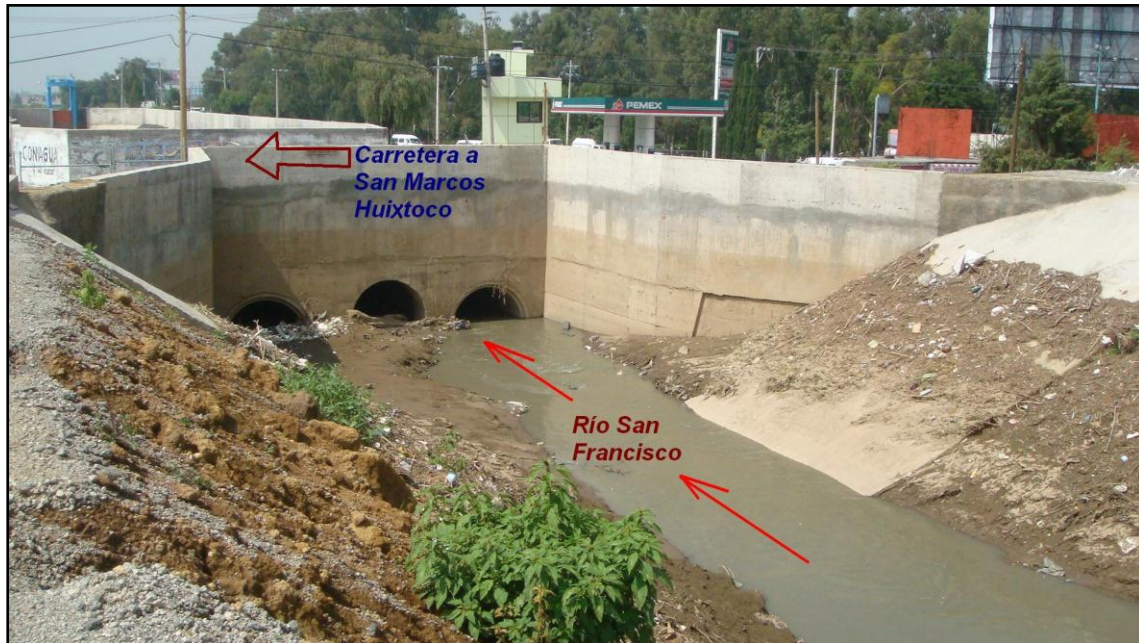
Fig 1.8.- Entrada de las alcantarillas en el cruce con la carretera
