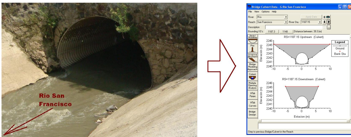
Fig 4.3.- Alcantarilla en cruce con autopista México-Puebla.
