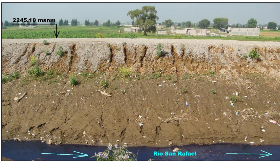
Fig 1.4.- Margen izquierda del tramo final del río San Rafael.
