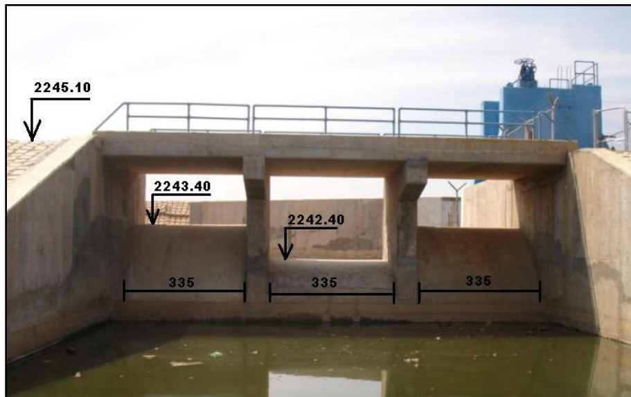
Fig 1.6.- Vertedor lateral de la derivadora San Rafael.
