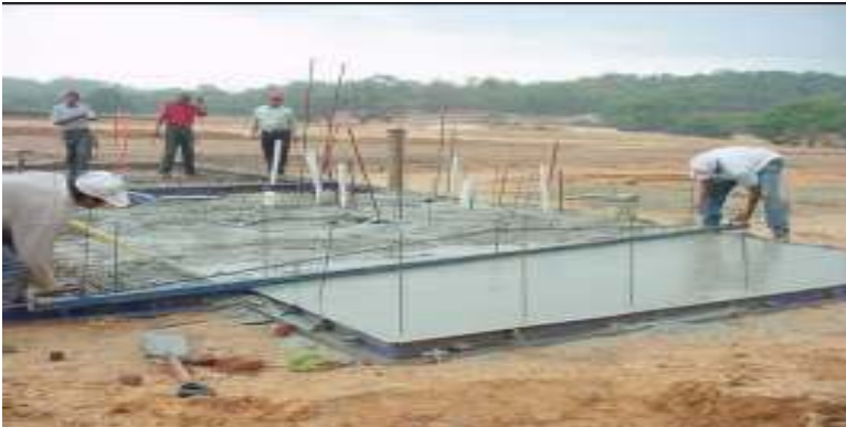
Gráfico 8. Colado de cimentación
