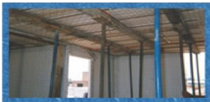
Gráfico 6. Cimbrado del techo de panel
