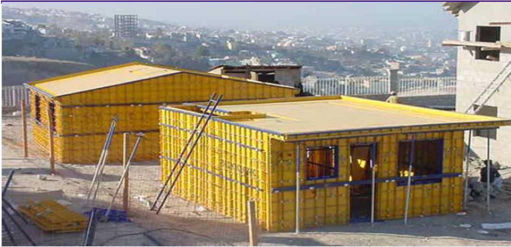
Gráfico 7. Cimbrado del sistema Meccano.
