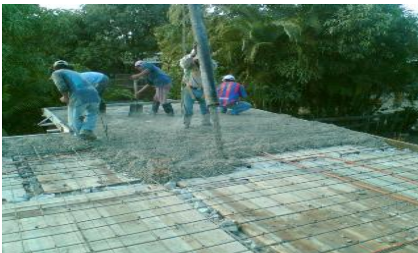
Gráfico 4. Colado de techo de concreto armado.
