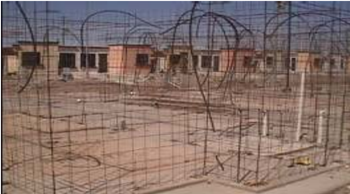
Grafico 12 Colocación de molde planta alta
