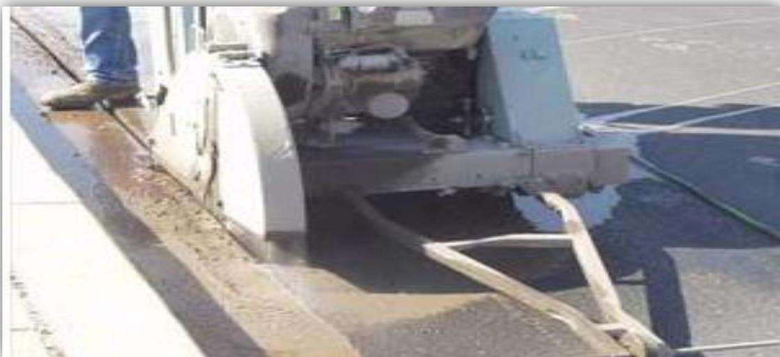
*Figura 4.3.2.2 Zanjado para fibra óptica.*
