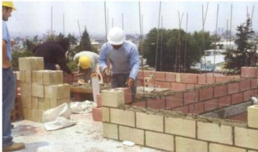
Figuras 5.29 Construcción con Block de concreto.
