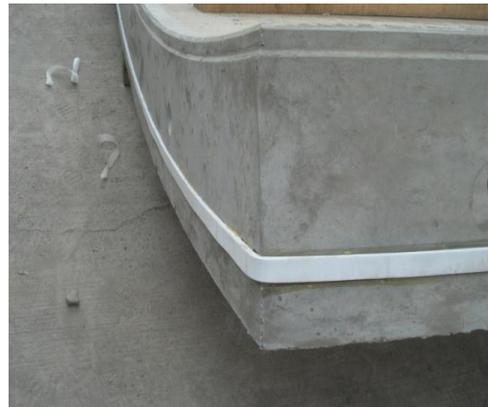
*Fig. 6 Colocación de sellos en las dovela*
