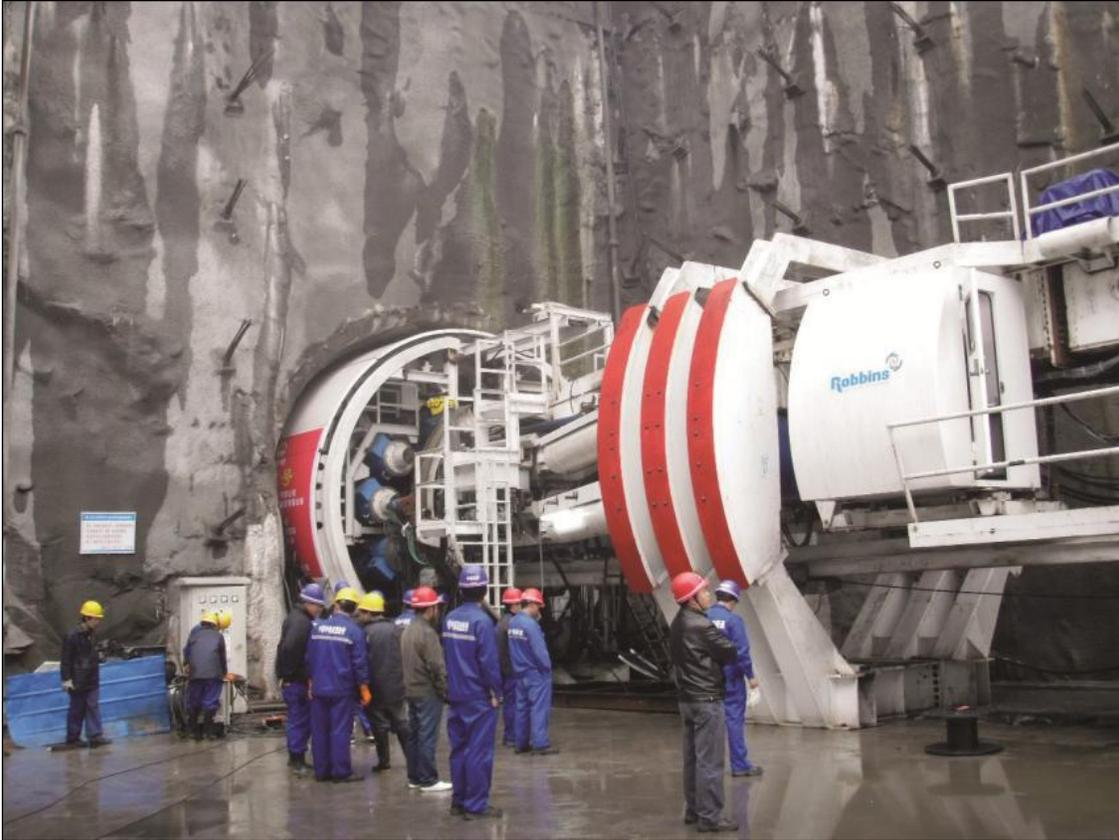
Chongqing Metro, Dos TBM's de Viga Principal de 6.3 m diámetro. 12 km (7.5 mi) de longitud con 8 estaciones.
