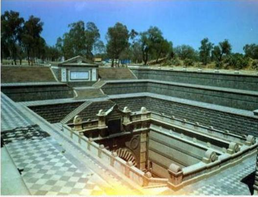
Caja colectora del Túnel de Tequiquiac, se observa parte de la entrada a la boca del túnel. Tequiquiac, Estado de México, 1973.
