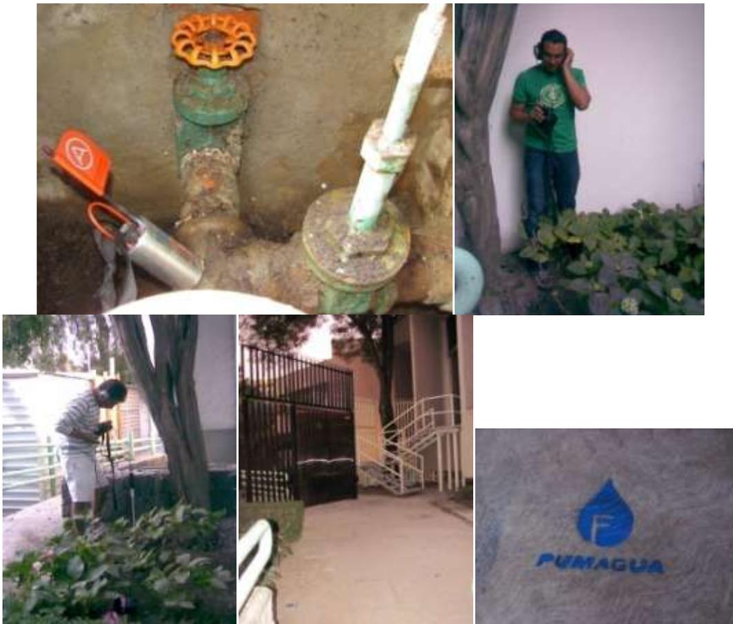
Figura 48. Correlación del tramo entre el R150 y R149 y confirmación de la fuga
