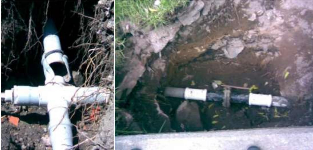
Figura 25. Fuga en PVC por asentamiento del terreno y su reparación en 2008
