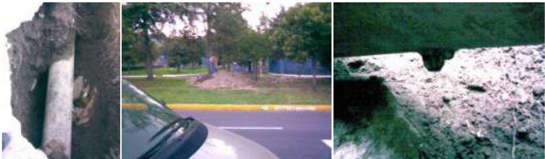
Figura 26. Fuga en fierro fundido de 12", tramo reparado por falla típica 5 veces en 3 años y su reparación (2008-2011)
