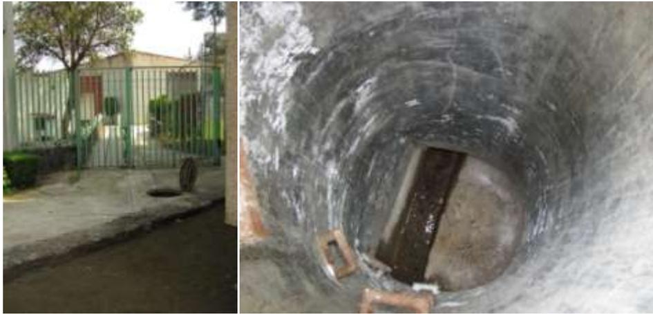
Figura 47. Verificación de flujo claro en el drenaje y audición de la posible caída en fuente cercana al pozo de visita
