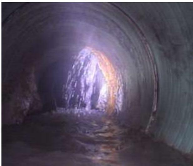
Figura 13. Intrusión de agua limpia a tubería de drenaje (fuente: Teasa)
