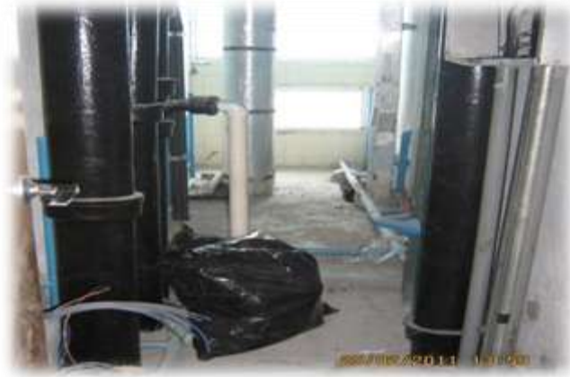
Figura 4. Almacenamiento por piso.
