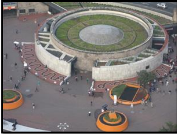
Fig. 1.4 Azotea Verde de la Glorieta de Insurgentes
