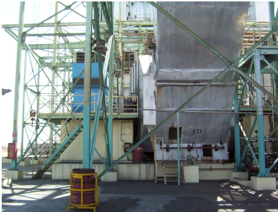
Fotografía N° 3. Vista lateral del VTI y su cimentación
