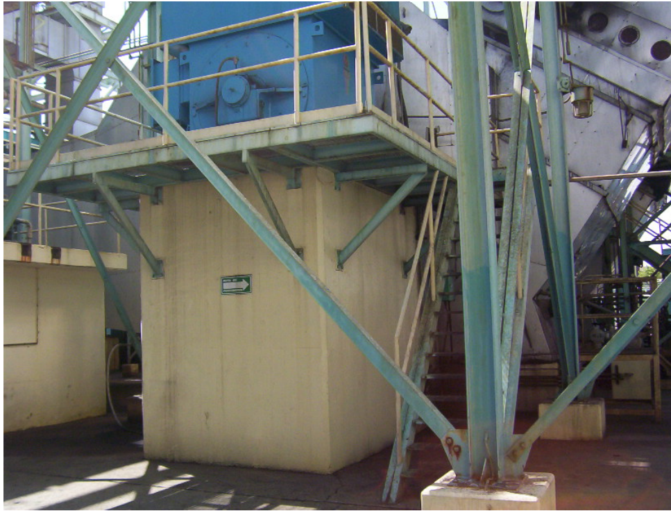
Fotografía N° 2. Vista del lado cople de la cimentación del VTI.
