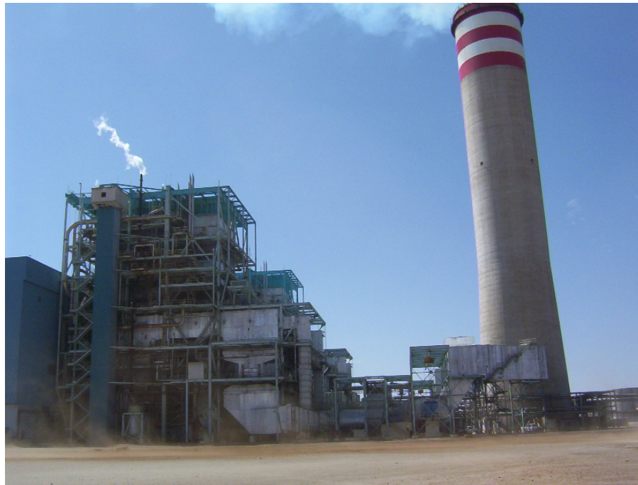
Fotografía N° 1. Vista general de la posición del VTI de la Central Villa de Reyes
