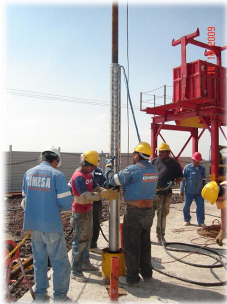
3.1.10 Colocación de sistema de bombeo
