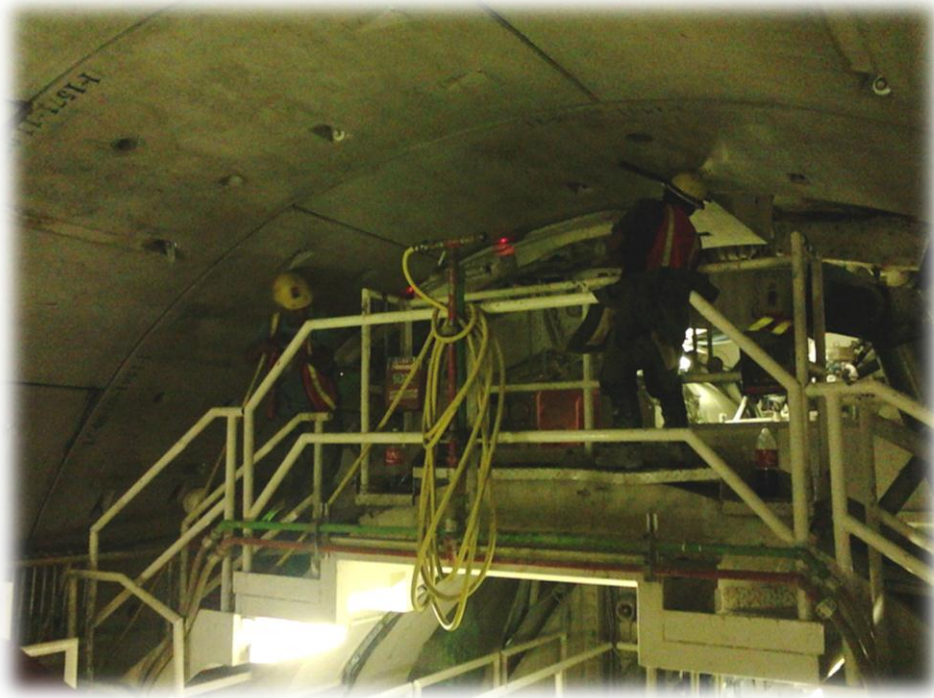
3.2.1 Brazo erector de escudo en la colocación de revestimiento primario (sistema de dovelas)
