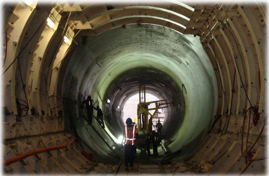
3.4.1 Colocación de cimbra telescópica para revestimiento definitivo
