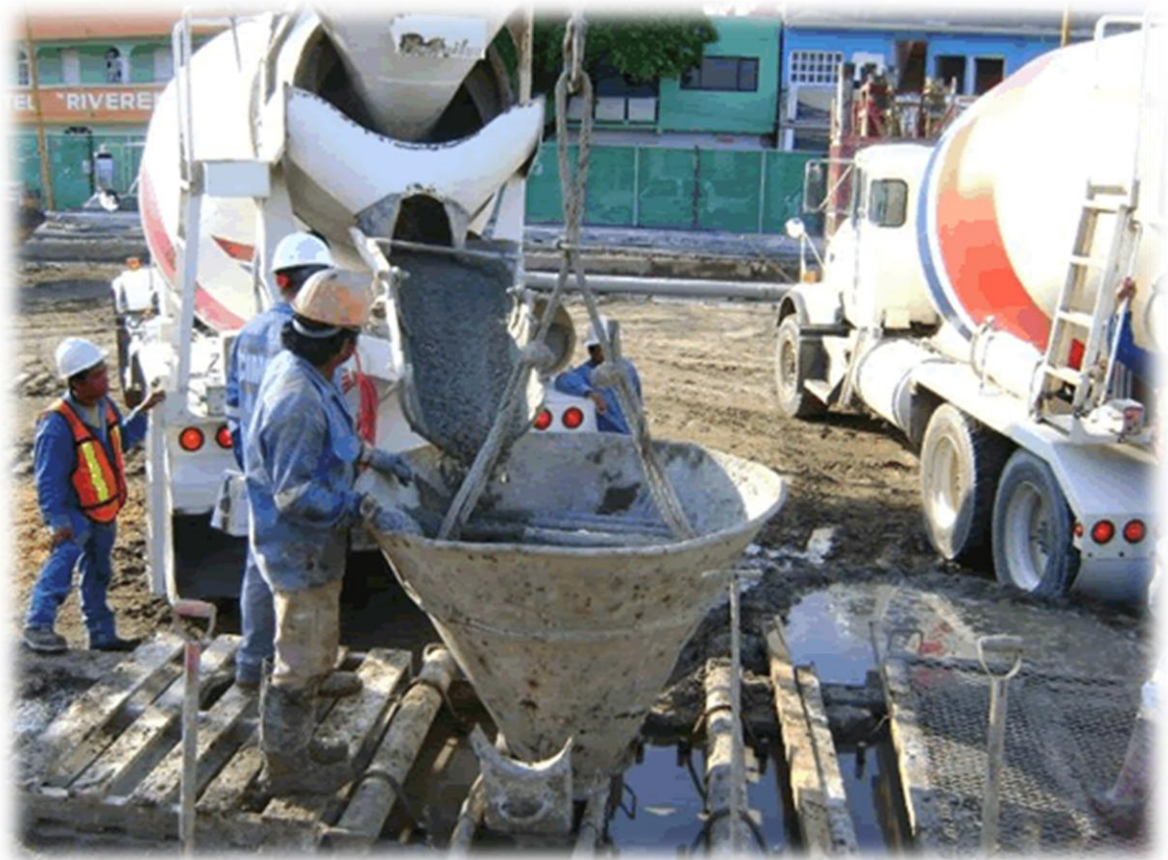
3.1.6 Colocación de concreto en muro Milán
