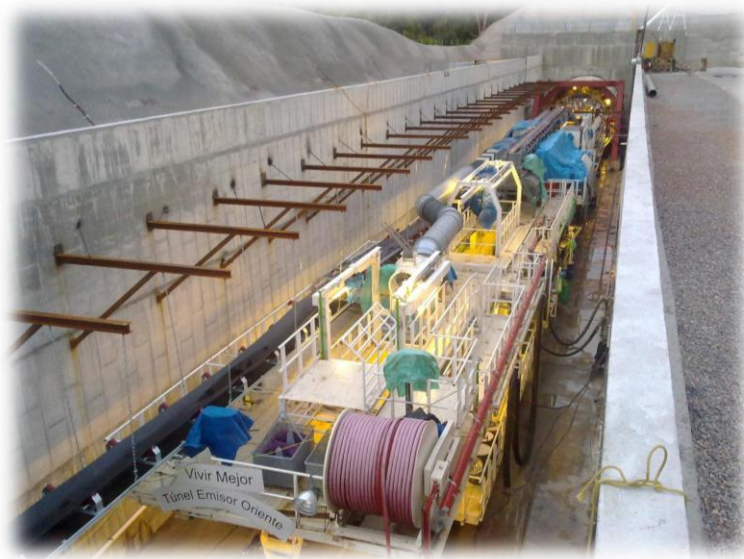
Colocación de escudo y tren de equipo en portal de salida
