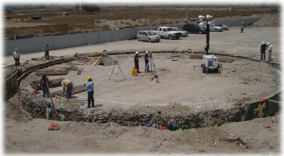
3.1.2 Preparativos para colocación de brocal
