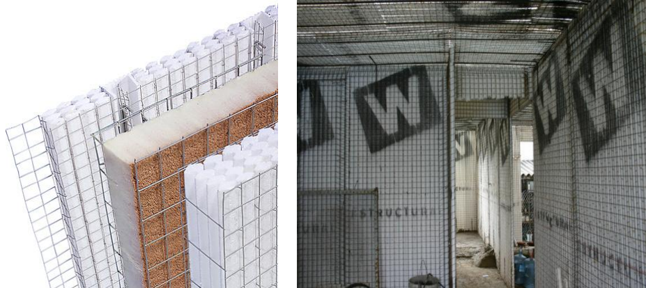
Figura 4.13. Panel W y construcción de una vivienda utilizándolo
