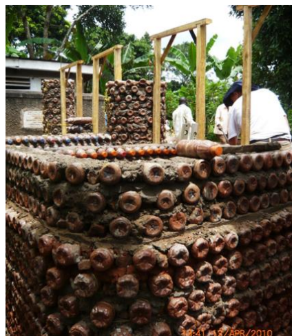
Edificaciones hechas con envases de PET rellenos de materiales térreos
