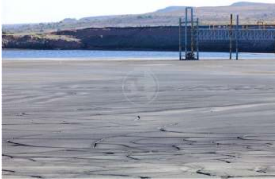
Figura 2: Superficie de una presa de jales, Sonora, México.
