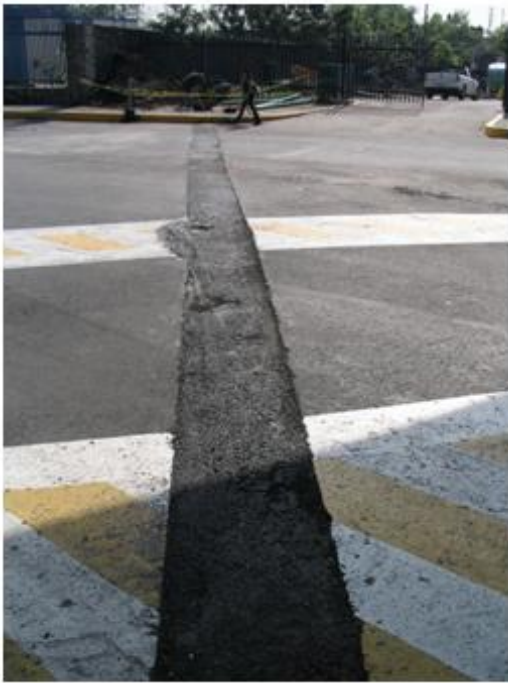
Figura 1.9 Acabado y Trayectoria Final
