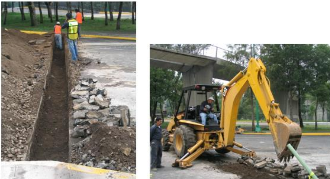
Figura 1.5 Construcción de la canalización
