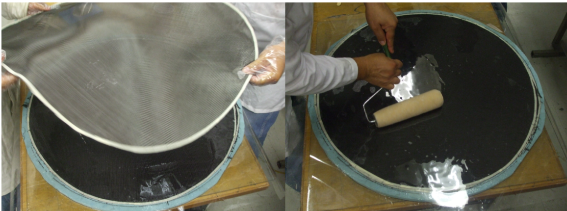
Figura 3.9. Dos etapas de construcción de la plataforma. Aplicación de las 2 capas de fibra de carbono y eliminación de burbujas.
