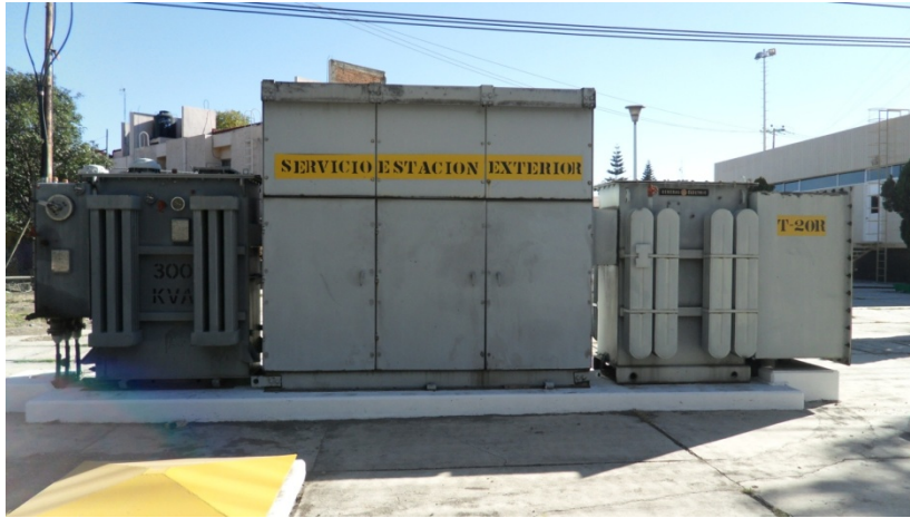
Figura C-13 Servicios propios de subestación (primario y respaldo)
