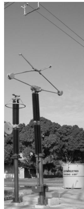
Figura C-6 Cuchillas tipo pantógrafo
