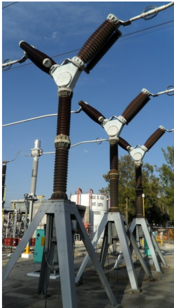
Figura C-2 Interruptor SF 6 tanque vivo
