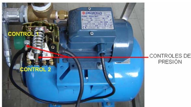
Figura 4.15. Controles de presión del hidroneumático
