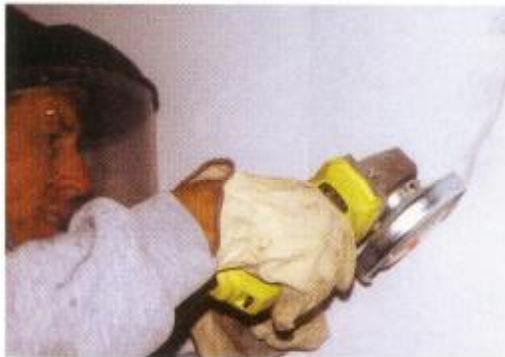
Fig. 5.10 Perfilado de una grieta con disco de diamante de 4 pulg (Trout, 2005)
