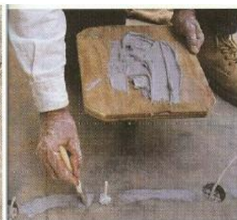
Fig. 5.29 Como preparación para sellar la grieta se aplica una capa de sellador entre puertos (Trout, 2005)
