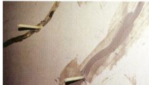
Fig. 5.13 Se observa que no existe desperdicio en el sellado (Trout, 2005)
