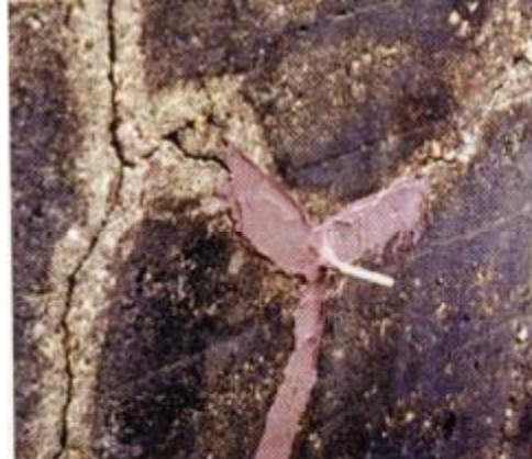
Fig. 5.20 El puerto de inserción se fija con el material de sellado (Trout, 2005)
