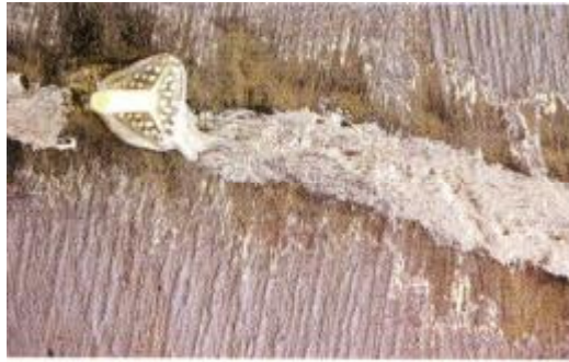
Fig. 5.18 Aplicación del sellador siguiendo puertos (Trout, 2005)
