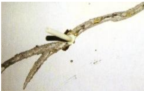
Fig. 5.12 Los puertos se colocan antes de aplicar el sellador (Trout, 2005)
