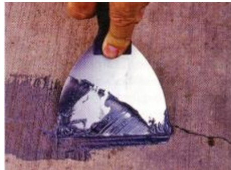
Fig. 5.7 El relleno epóxico se coloca con una espátula de metal flexible (Trout, 2005)
