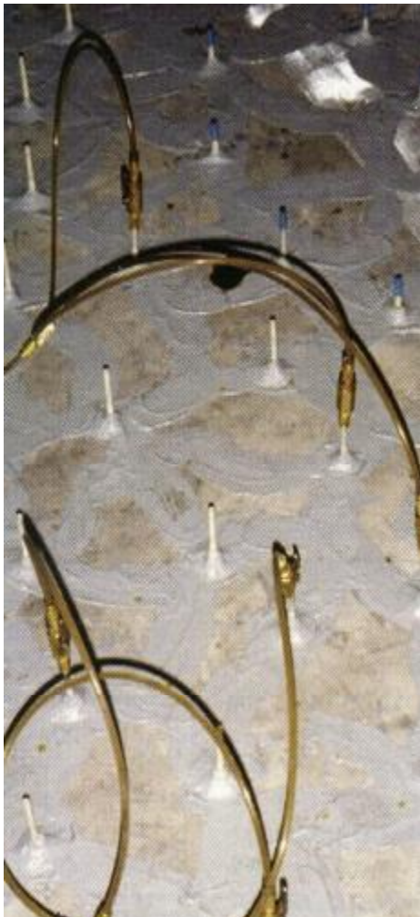
Fig. 5.34 Los puertos múltiples permiten inyectar varios puertos de la misma grieta (Trout, 2005)
