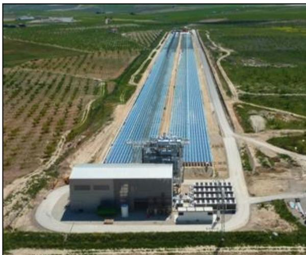
Figura 3.24: Vista aérea de una planta de Fresnel, Murcia, España.
