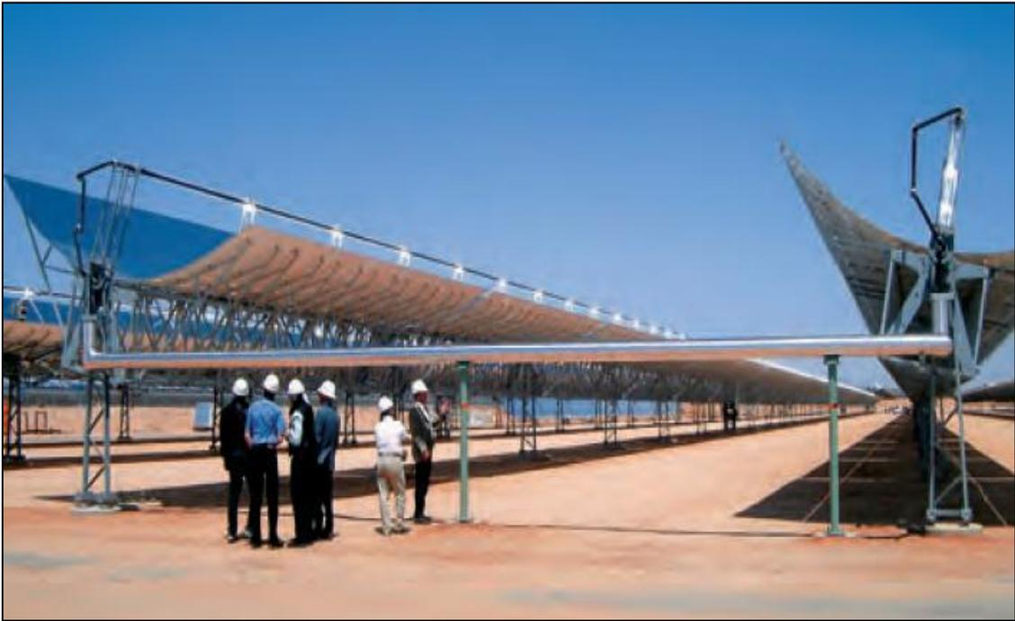
Figura 3.8: Central termosolar tipo concentradores Cilíndrico-Parabólico.
