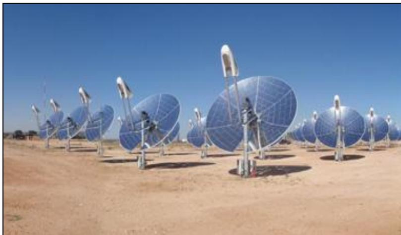
Figura 3.16: Central eléctrica termosolar tipo colector disco Stirling.
