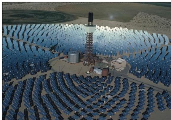
Figura 3.10: Central termosolar Tipo Concentrador de Torre Central.
