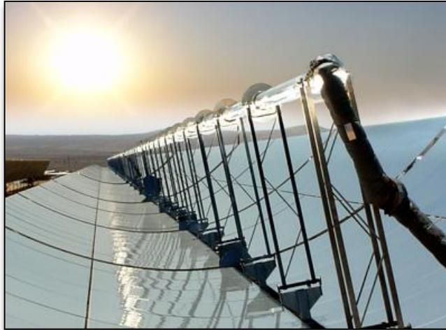
Figura 3.6: Concentrador Cilíndrico-Parabólico.
