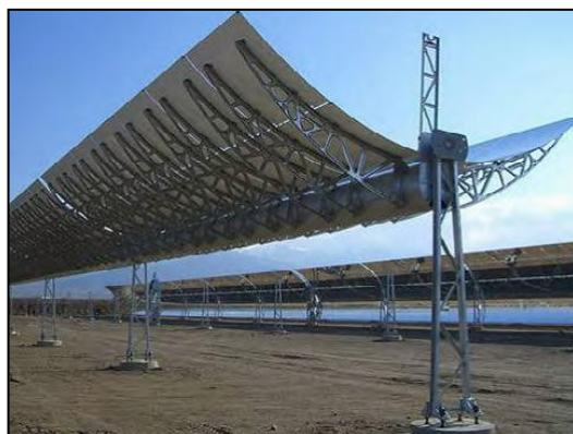
Figura 4.11: Colector en la planta Andasol-1.
