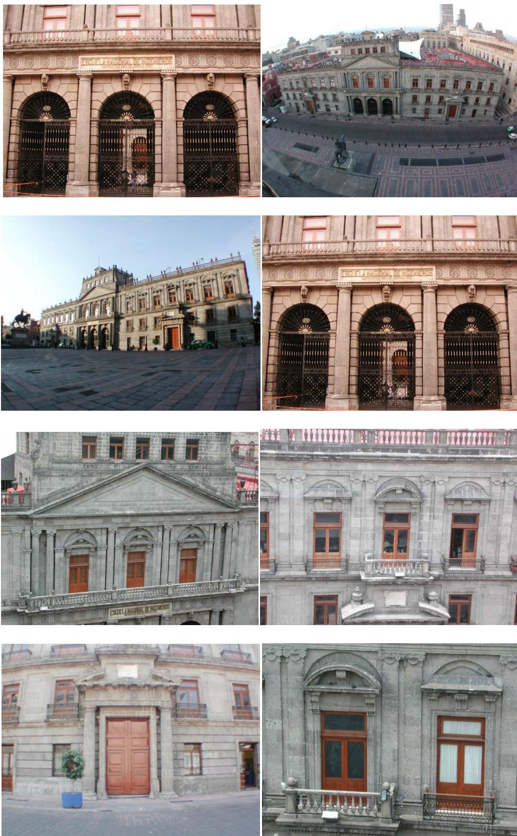
Figura 32 Fotografías de referencia de la fachada
