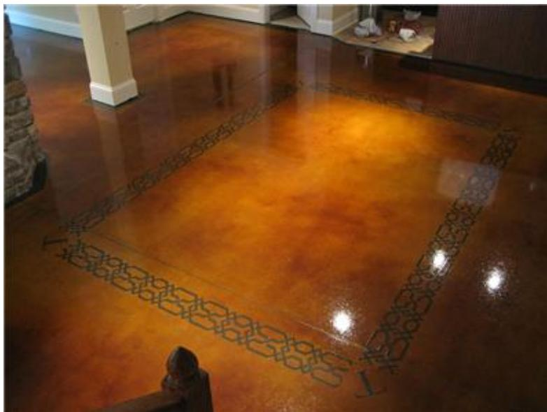
Fig. 4.6. La imagen muestra un piso coloreado a base de ácidos oxidantes de concreto.
