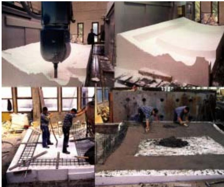
Fig. 2.11. Desintegración de paneles de poliestileno, para la generación de paneles de concreto reforzado. Edificio Zollhof Tower en Dusseldorf, Alemania. Arq. Frank Gehry.
