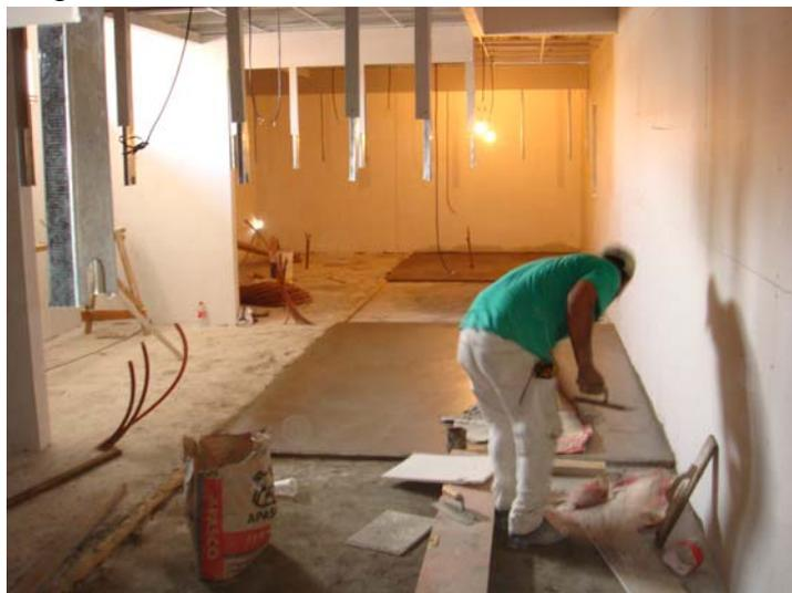
Fig. 6.1. Realización de los tableros de concreto pulido
