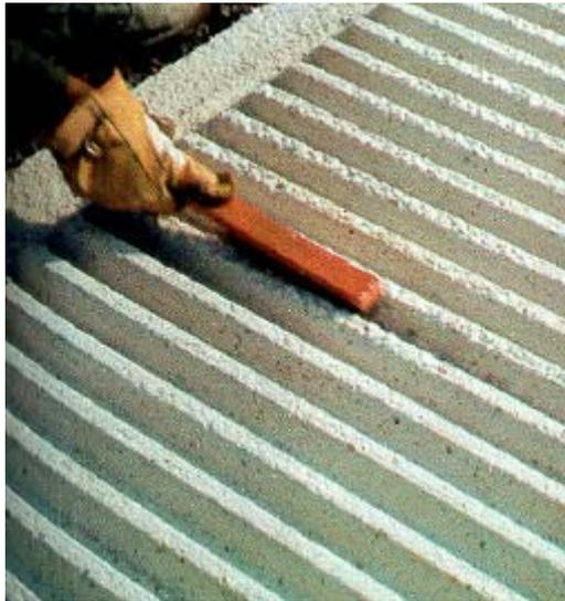
Fig. 3.17. Acabado por medios manuales
