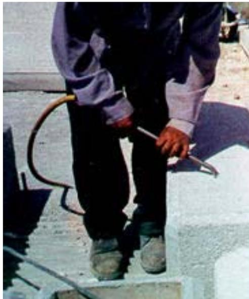
Fig. 3.18. Desescamado de concreto por medios mecánicos
