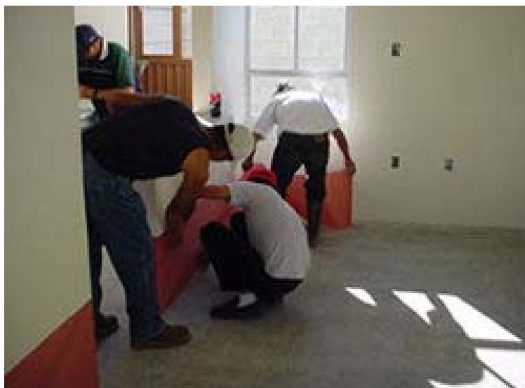
Fig. 4.10. Protección de superficies con enmascarillado
