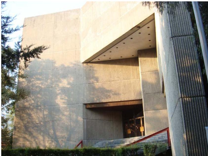
Fig. 3.4. Acabado en concreto con patrones. Sala Netzahualcóyotl, México.
