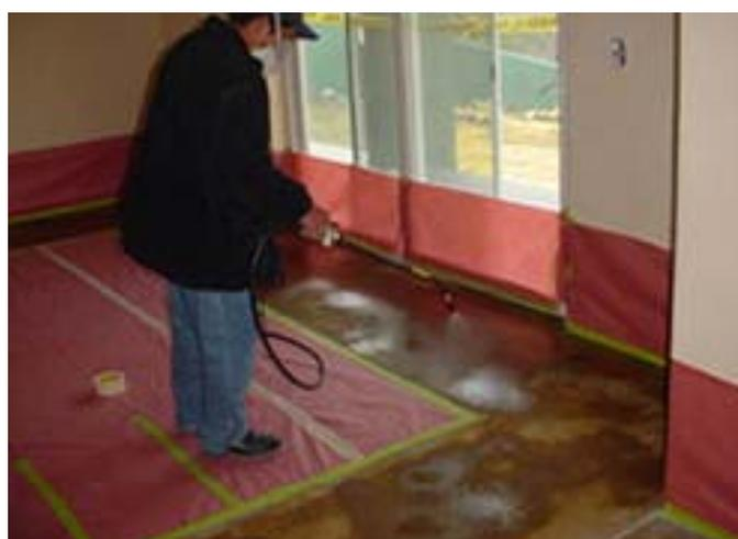
Fig. 4.11. Aplicación del oxidante en un piso.
