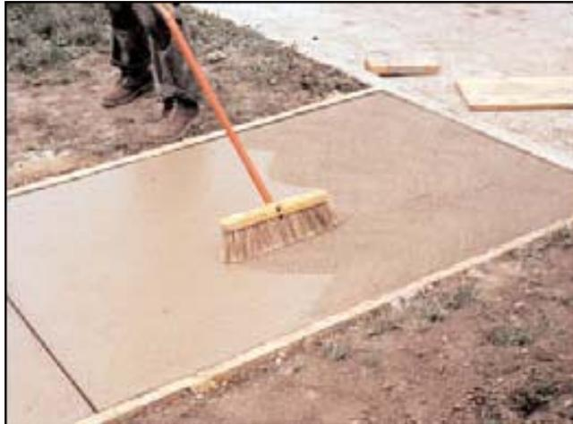
Fig. 3.7. Acabado escobillado en firme
