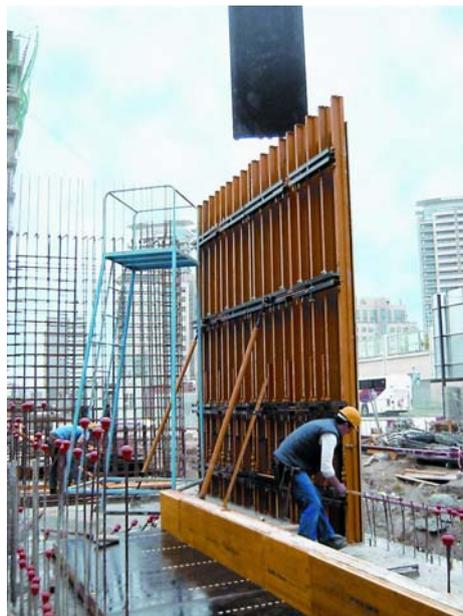
Fig. 2.8. Colocación de una hoja de cimbra metálica
