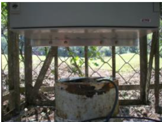
Montaje del gabinete
