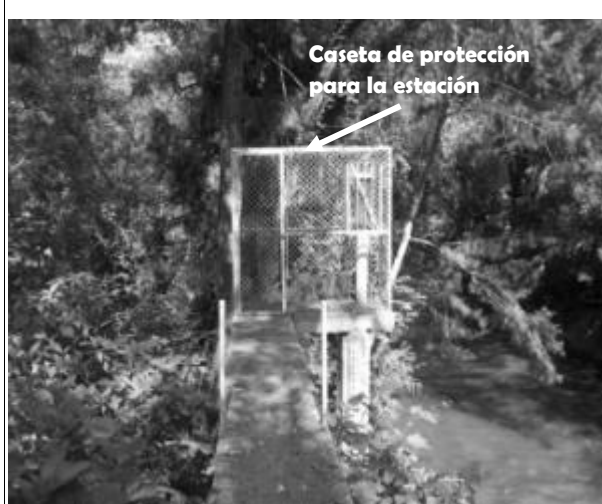
Vista de la estructura desde la carretera
