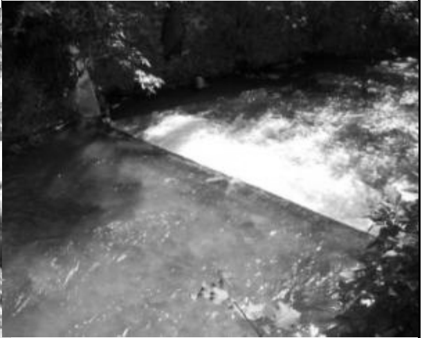
Vista del vertedor
