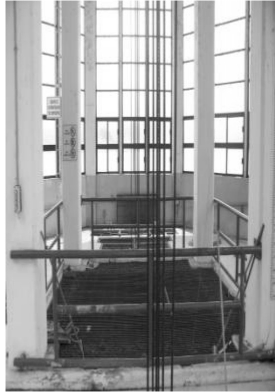
Vista interior de la Obra de Toma
