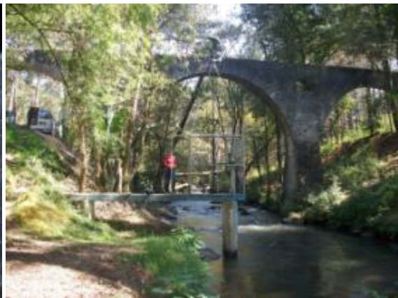
Estación hidrométrica automática
