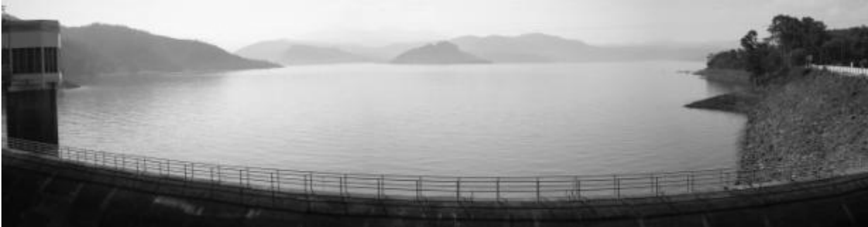
Vista de la obra de toma y cortina de la Presa Valle de Bravo
