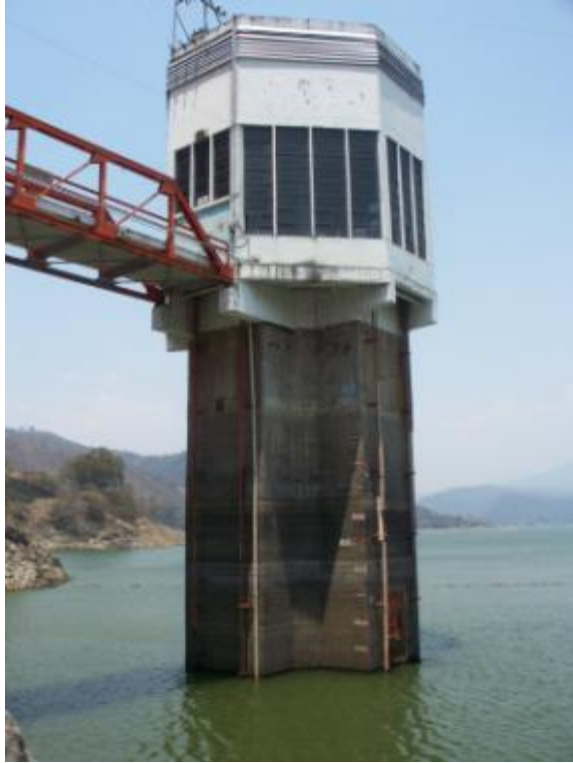
Detalle de la obra de toma
