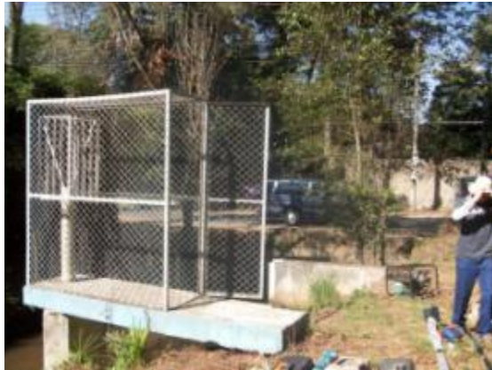
Sitio de la instalación
