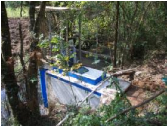
Sitio de la instalación
