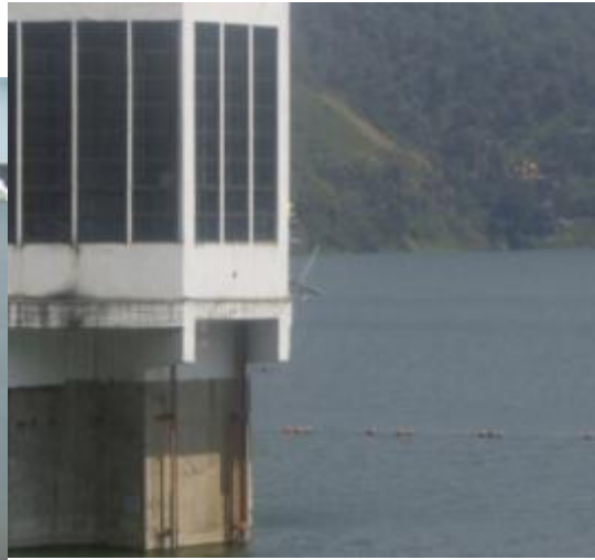
Estación hidrométrica automática
