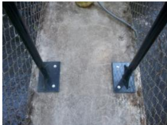
Fijación de la base de la estructura
