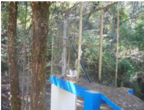
Sitio de la instalación
