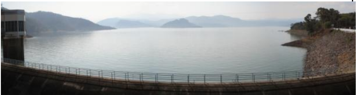
Vista de la obra de toma y cortina de la Presa Valle de Bravo
