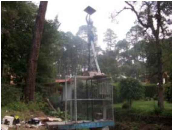
Instalación de la antena y del panel solar
