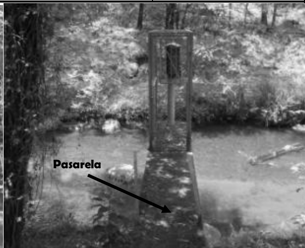
Pasarela de concreto hacia la estación
