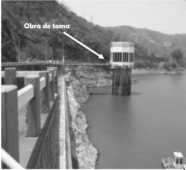
Vista Panorámica de la Obra de Toma
