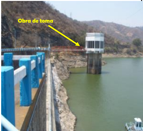
Vista Panorámica de la Obra de Toma
