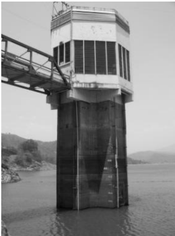
Detalle de la obra de toma
