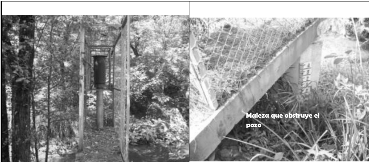
Estación convencional "Santa Mónica"
