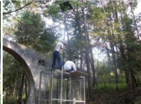
Montaje de la estructura
