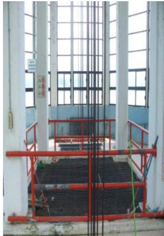
Vista interior de la Obra de Toma
