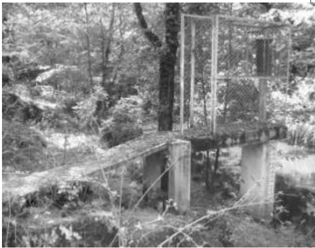
Estación convencional "Vertedor González"
